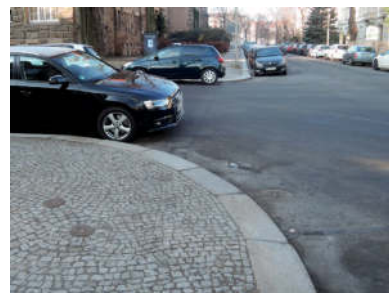
Abb. 52: Bordsteinkante Ecke Helmholtzstraße
