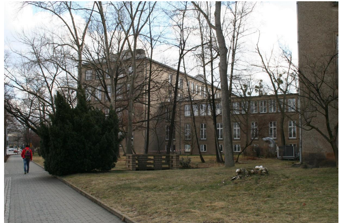
Blick von Nürnberger Straße auf Potthoff-Bau
