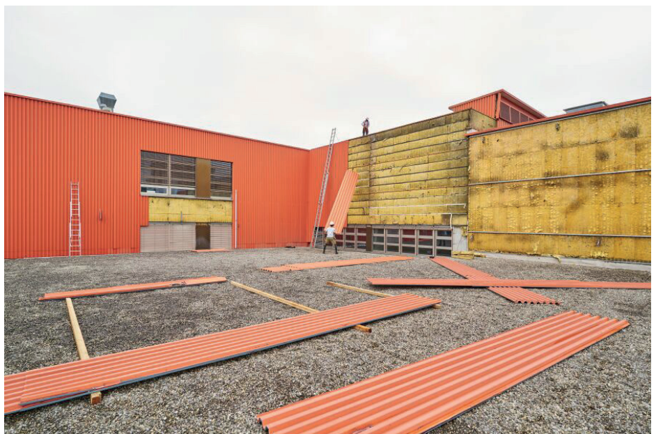
Abb.10 Rückbau Fassadenblech für K118 , Winterthur (CHE), 2020
