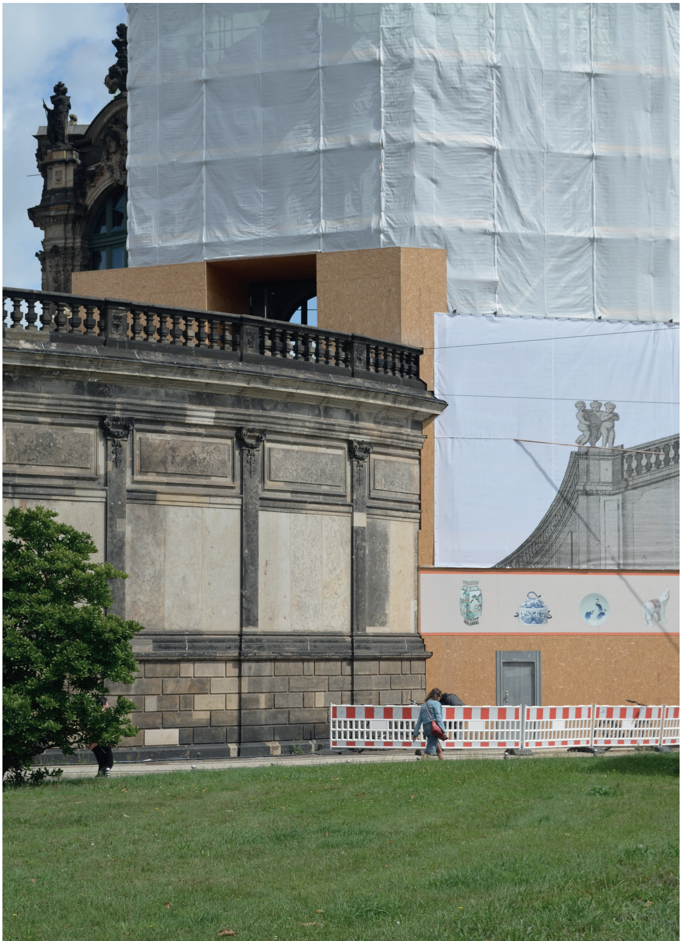
Abb.15 Die endlose Reparatur - Dresdener Zwinger während Instandsetzungsmaßnahmen, Dresden 2023
