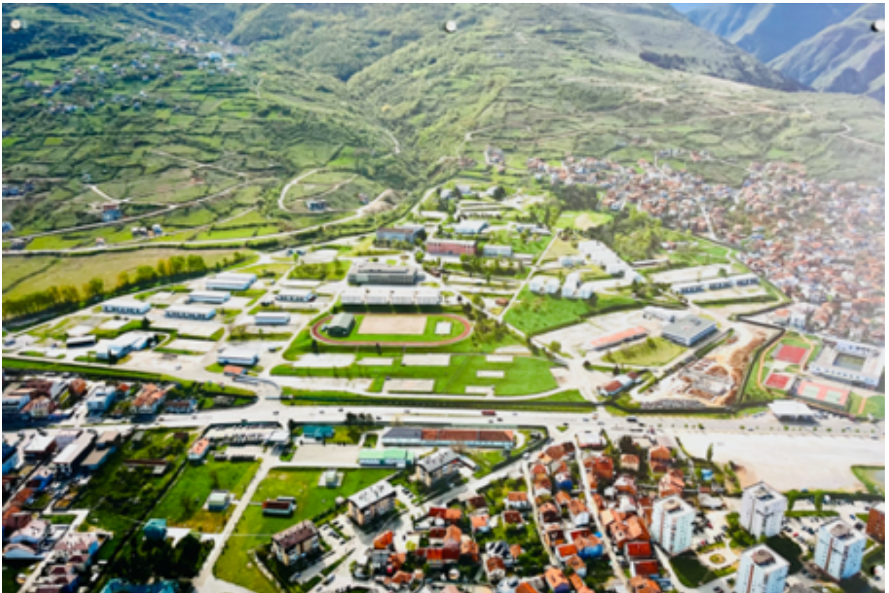
Schrägluftbild ehemalige KFOR Kaserne in Prizren (Kosovo)
