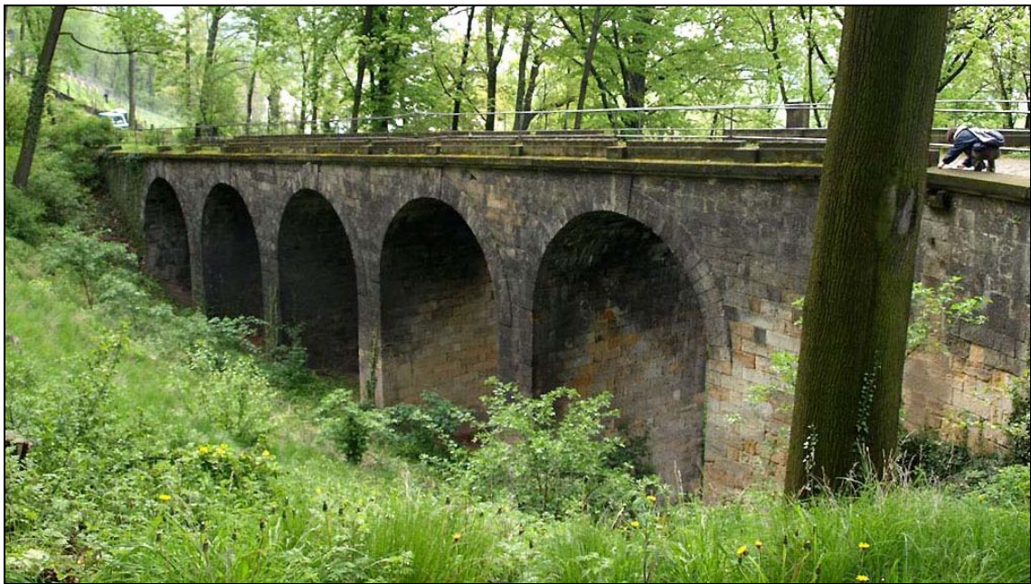
Abb. 2: Viadukt, Blick von Nordwesten, Foto: Edelmann April 2008.
