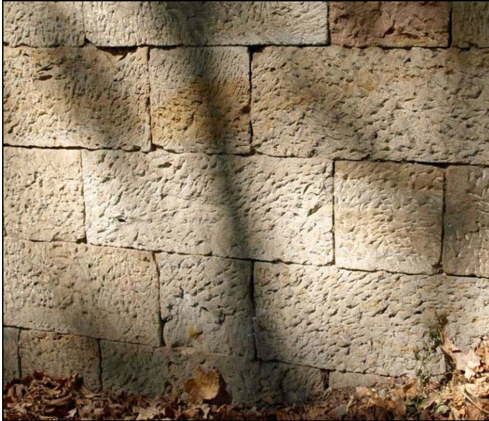
Abb. 3a: Unverfugtes, gespitztes Quadermauerwerk des Viaduktes (Sichtbereich), Foto: Blask/ Edelmann April 2008.
