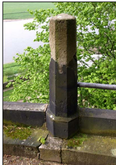
Abb. 10: Kurve am unteren Ende des Viaduktes, umgeworfene, zerstörte und unsachgemäß reparierte Pfeiler im Kurvenbereich, Foto: Blask/ Edelmann April 2008.
