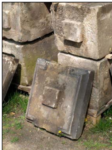
Abb. 4a-c: Brüstung des Viaduktes: passgenaue Bearbeitung der Werksteine, rechts: intakter Brüstungsabschnitt, Fotos: Blask/ Edelmann April 2008.
