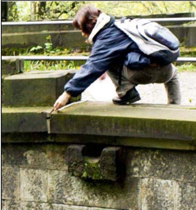
Abb. 14: Sandsteinerne Speisteine zur Entwässerung der Fahrbahn, Foto: Edelmann April 2008.
