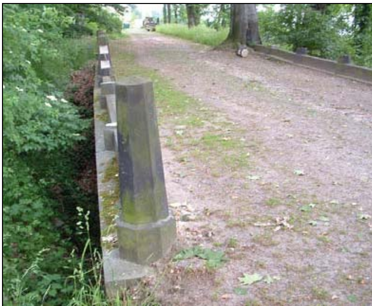
Abb. 46a-b: Brücke unterhalb des Viaduktes, Ausbeulung/ Neigung der nördlichen Stirnwand, Foto/ Skizze: Seidel 2008.
