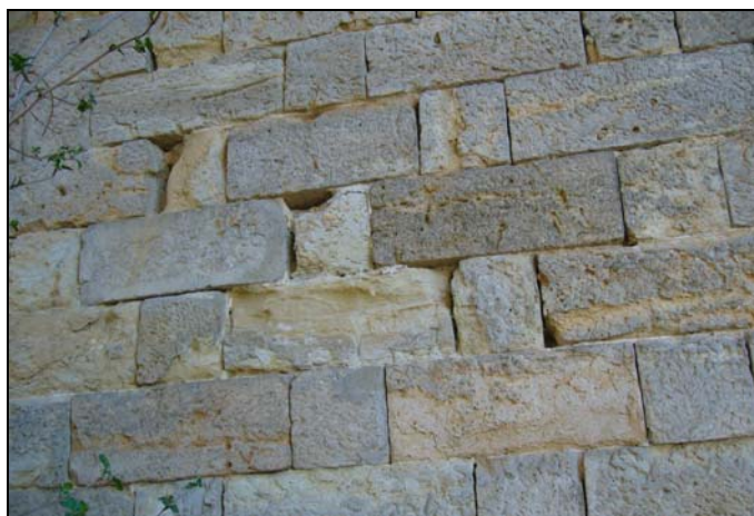
Abb. 9: Steinverwitterung zwischen 2. und 3. Bogen, Foto: Blask/ Edelmann April 2008.
