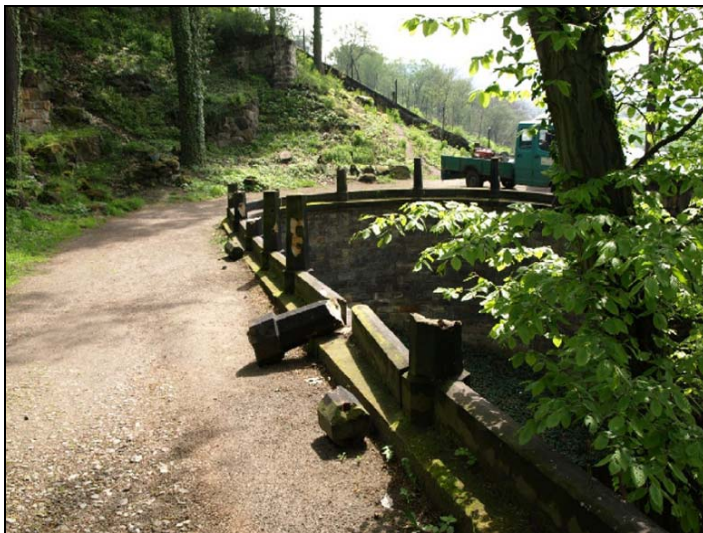
Abb. 10: Kurve am unteren Ende des Viaduktes, umgeworfene, zerstörte und unsachgemäß reparierte Pfeiler im Kurvenbereich, Foto: Blask/ Edelmann April 2008.
