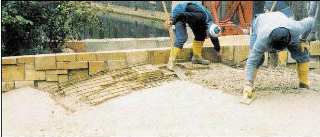
Abb. 13: Einbau einer Betonbewehrung über Gewölbemauerwerk, Foto aus: VOCKRODT, FEISTEL, STUBBE 2003, S. 266.
