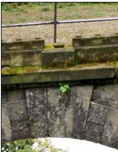
Abb. 4a-c: Brüstung des Viaduktes: passgenaue Bearbeitung der Werksteine, rechts: intakter Brüstungsabschnitt, Fotos: Blask/ Edelmann April 2008.
