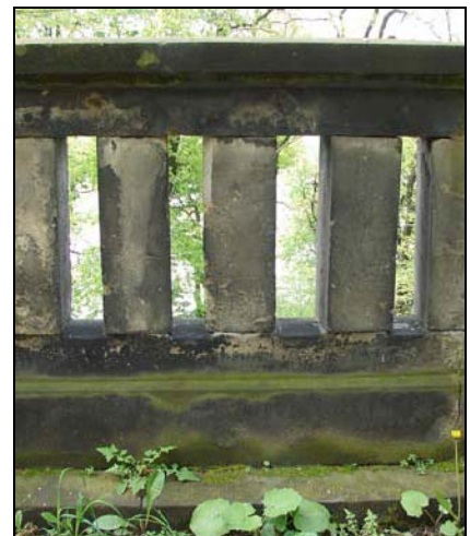
Abb. 4a-c: Brüstung des Viaduktes: passgenaue Bearbeitung der Werksteine, rechts: intakter Brüstungsabschnitt, Fotos: Blask/ Edelmann April 2008.
