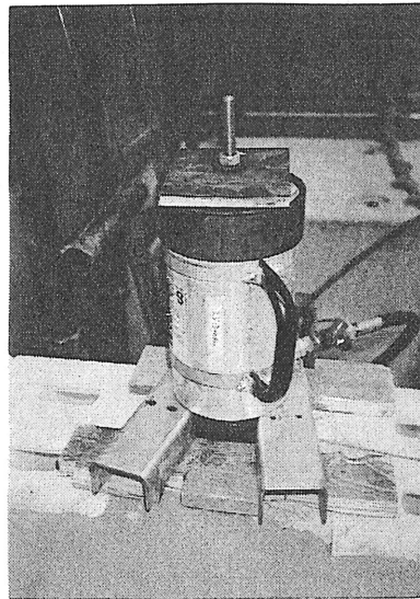
Abbildung 5.4.11: Vorspannen der Vertikalanker
