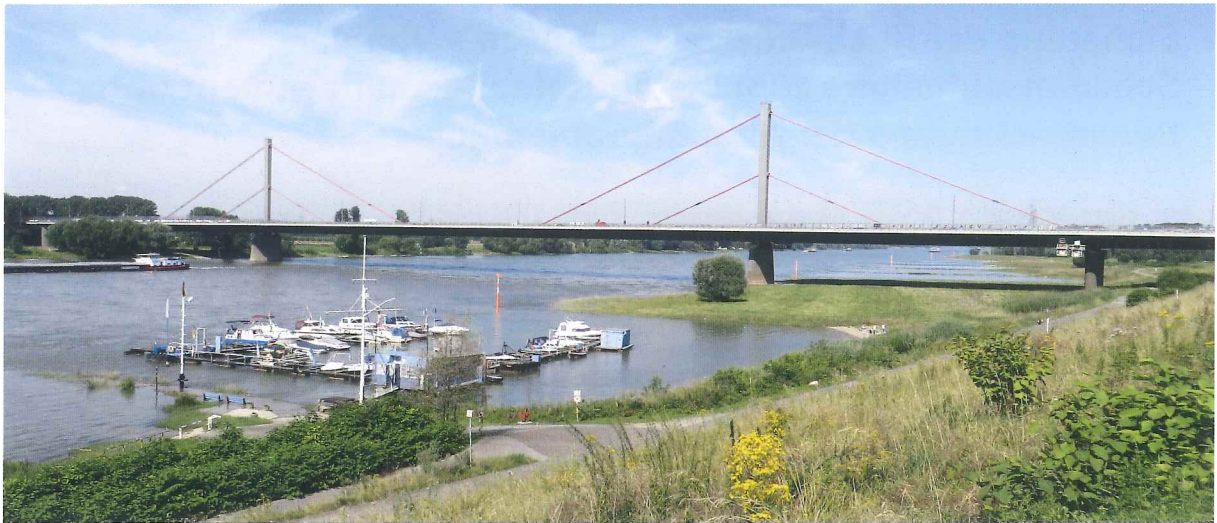
Bild 11.1: Rheinbrücke Leverkusen (Quelle: Straßen.NRW)
