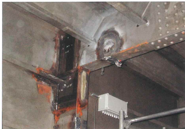
Bild 11.7: Instandsetzung der Rahmenecken mit Blechaustausch (Quelle: Straßen.NRW)
