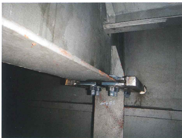
Bild 11.7: Instandsetzung der Rahmenecken mit Blechaustausch (Quelle: Straßen.NRW)
