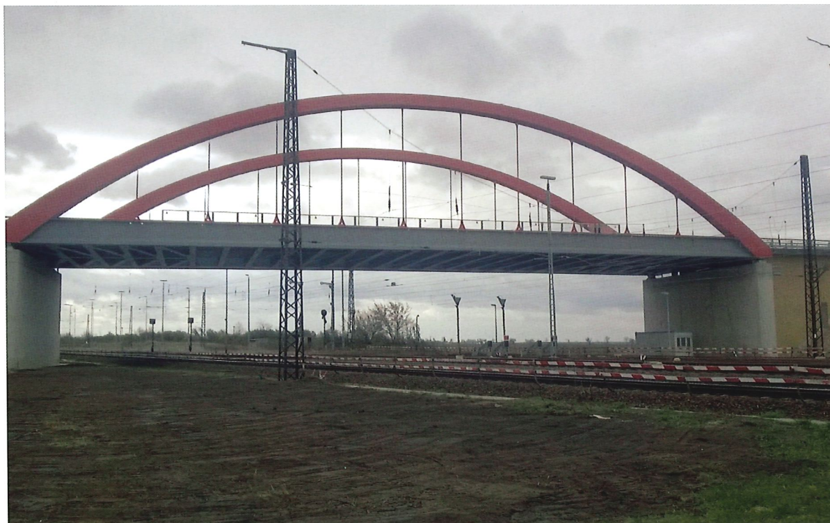
Seitenansicht (Quelle: Landesstraßenbaubehörde Sachsen-Anhalt, Regionalbereich Ost)
