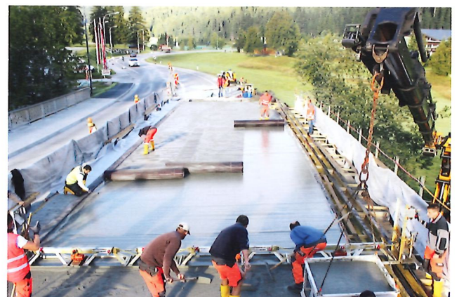
Bild 7.19: Gesamtübersicht, Herstellung Textilbetonschicht (BA2) (Foto: Mario Hansl)
