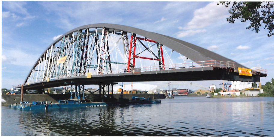
Bild 15.9: Einschwimmen der Brücke über den Main im Frankfurter Osthafen (Foto: Martin Joppich, Frankfurt am Main)
