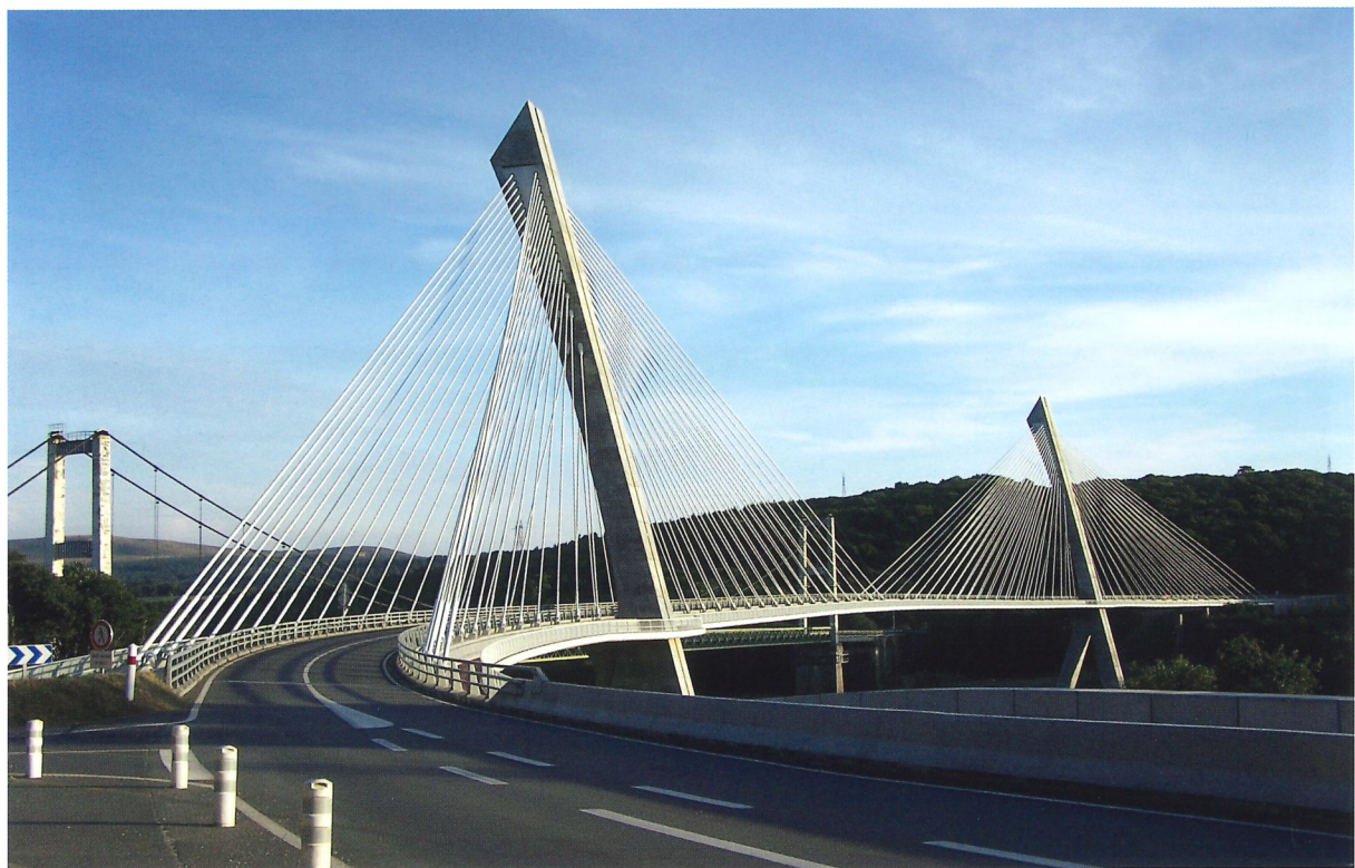
Bild 4.5: Pont de Térénez im Abendlicht (Foto: Bergfalke2, CC BY-SA 3.0, Wikimedia Commons)
