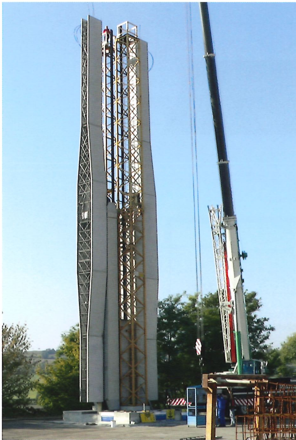
Bild 13.22: Großversuch für die Ausführung der S7-Brücken: Brücke in Bauphase 2 (Foto: TU Wien)
