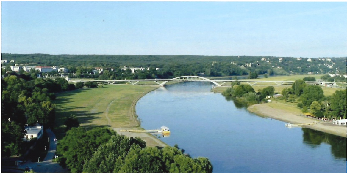
Bild 3.22: Waldschlösschenbrücke Dresden (Foto: Torsten Bach)
