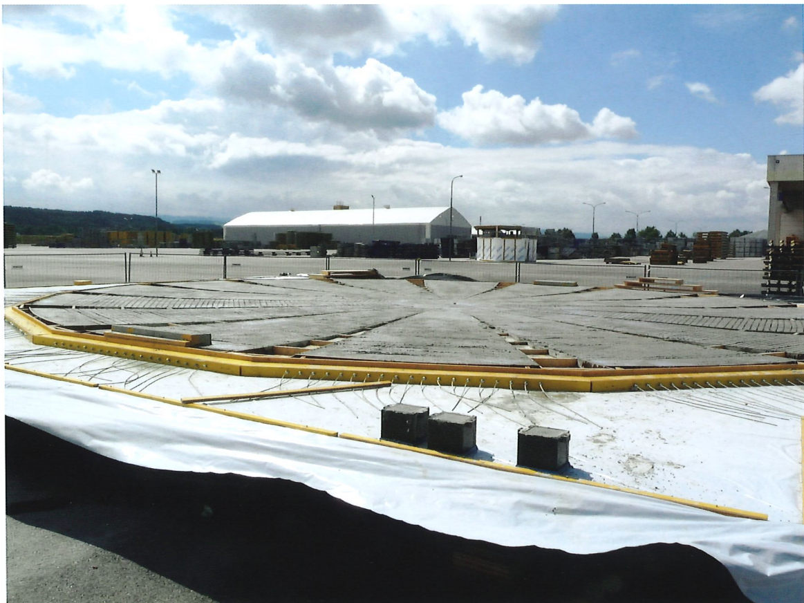
Bild 13.13: Ebene Betonplatte (Foto: TU Wien)
