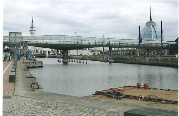
Bild 17.19: Gläserne Brücke, Bremerhaven (Foto: Sebastian Wilhelm)
