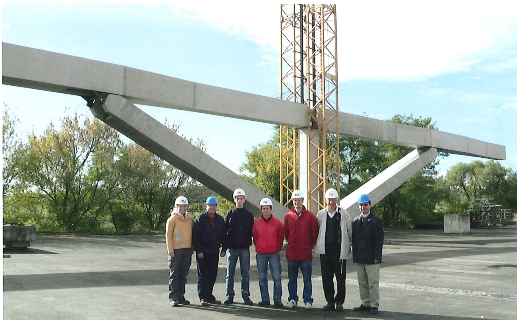
Bild 13.24: Fertiggestellter Großversuch für die Ausführung der S7-Brücken (Foto: TU Wien)
