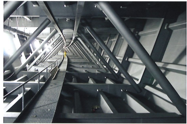
Bild 17.9: Stahlhohlkasten der Talbrücke Nuttlar (Foto: Sebastian Wilhelm)
