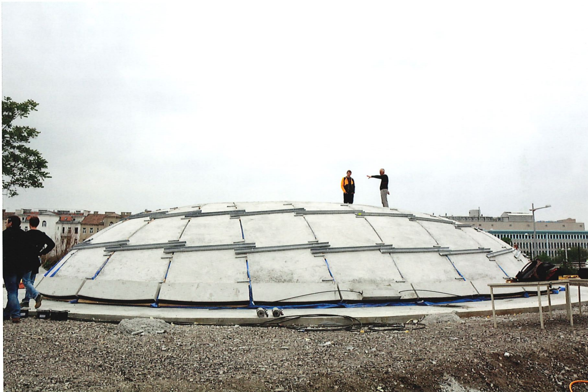
Bild 13.17: Fertiggestellte Freiformschale (Foto: TU Wien)
