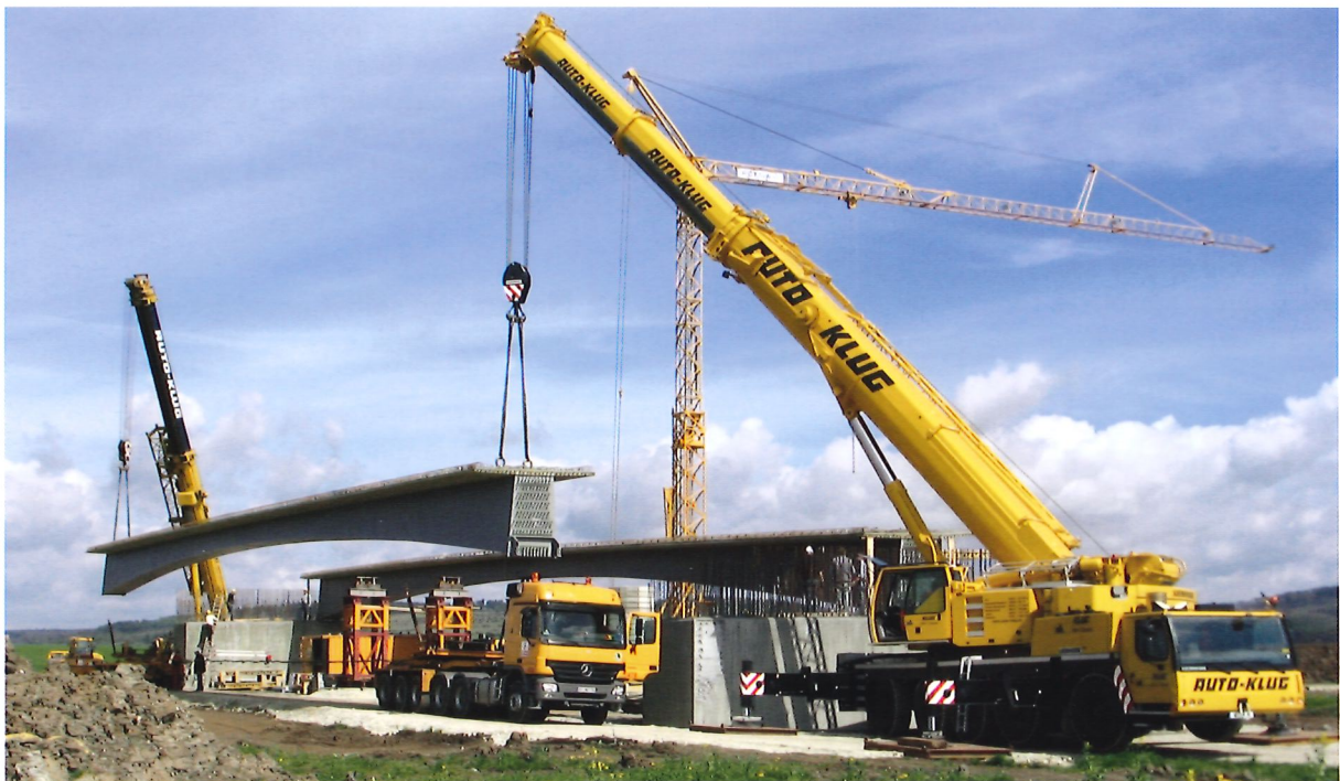
Bild 15.2: Einheben von Brückenbauteilen, (Foto: Alfred Klug GmbH & Co. KG)
