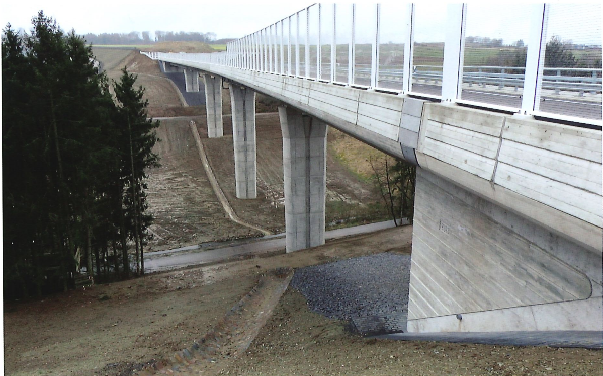
Seitenansicht (Quelle: Landesbetrieb Mobilität Rheinland-Pfalz, Landesbetrieb Mobilität Bad Kreuznach)
