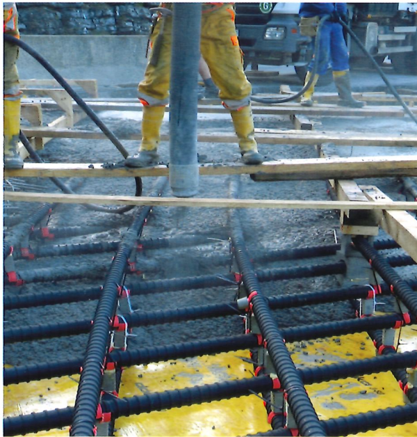
Bild 13.7: Betonieren des Tragwerks (Foto: TU Wien)
