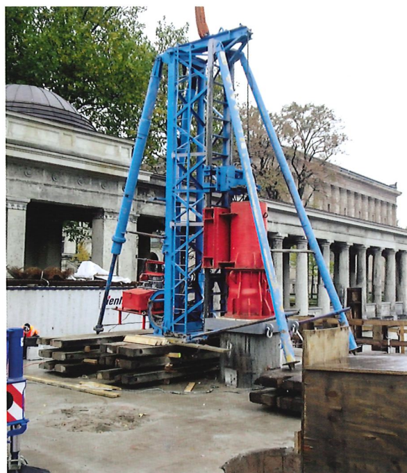
Bild 12.11: Dynamische Pfahlprobebelastung (Foto: Steffen Metzner, ibb Mangold mbH Berlin)
