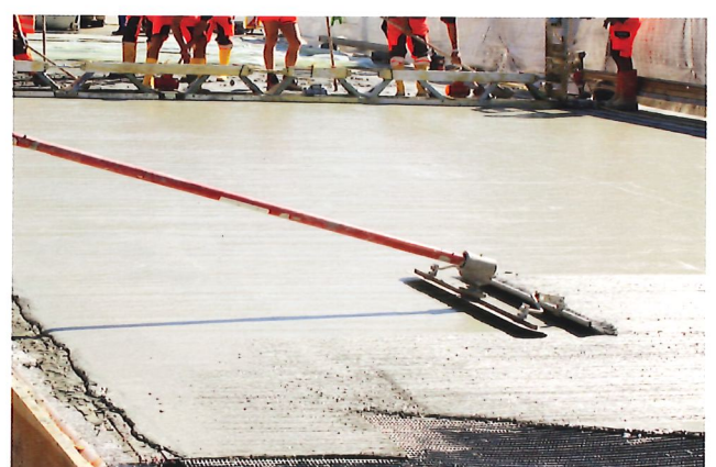
Bild 7.21: Herstellung des Besenstrichs (BA2) (Foto: Mario Hansl)
