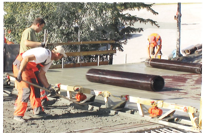
Bild 7.17: Arbeiten mit Abziehbohle (BA1) (Foto: Mario Hansl)
