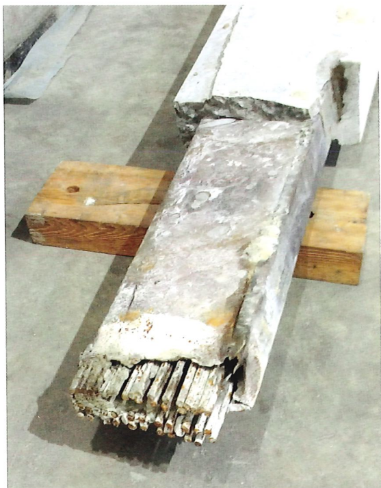
Bild 8.20: Spanngliedteil, herausgesägt aus dem Endquerträger (Foto: Luc Taerwe)
