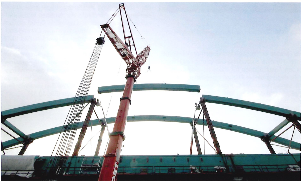
Bild 10.12: Bogenmontage (Foto: DB AG)
