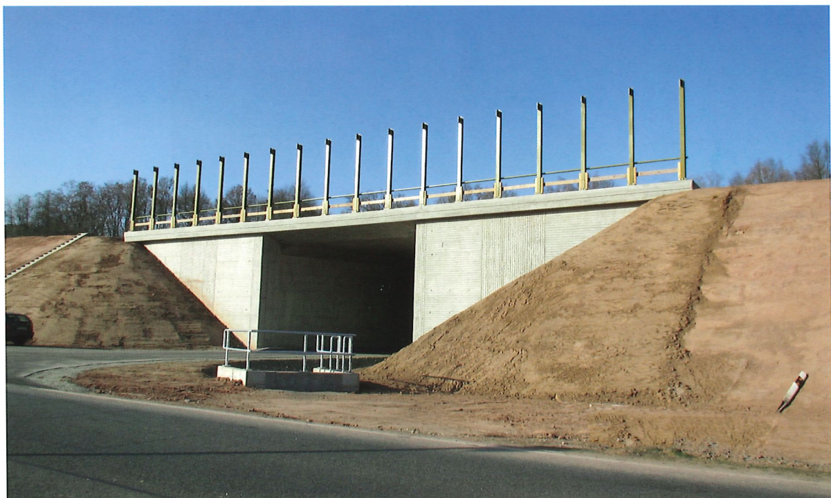
Brücke im Bauzustand, Ansicht Süd (Quelle: Hessen Mobil)
