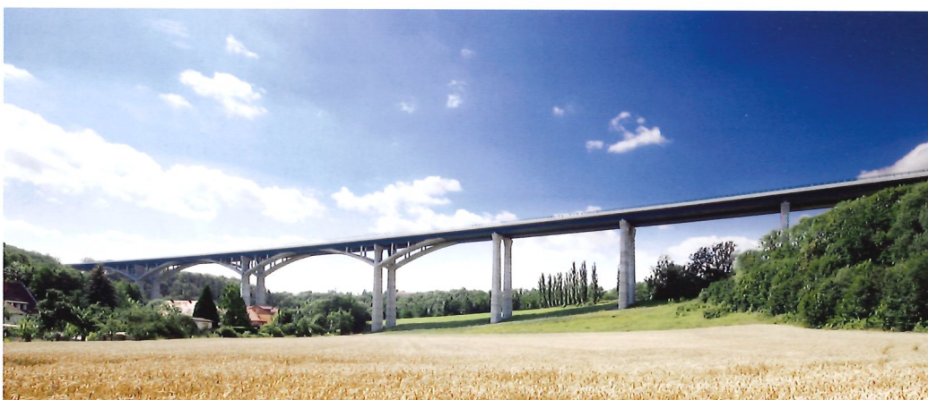
Bild 3.4: Lockwitztalbrücke, BAB 17 Dresden–Prag (Foto: LAP CONSULT)
