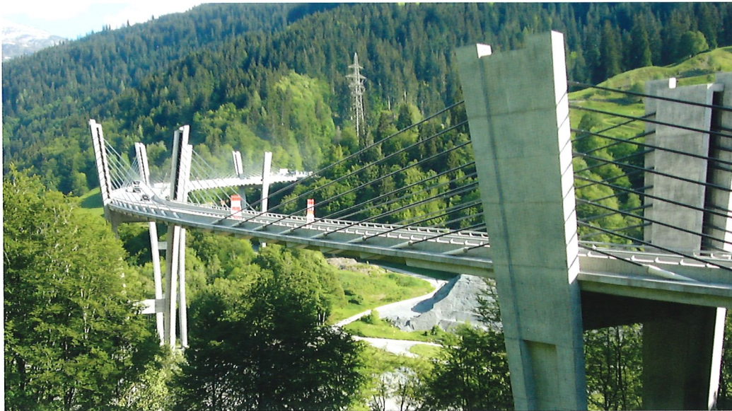
Bild 9.8: Sunnibergbrücke, Schweiz (Foto: Fachgebiet Massivbau, TU Darmstadt)
