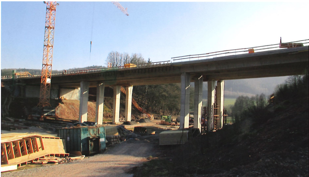
Brücke im Bauzustand (Quelle: Hessen Mobil)
