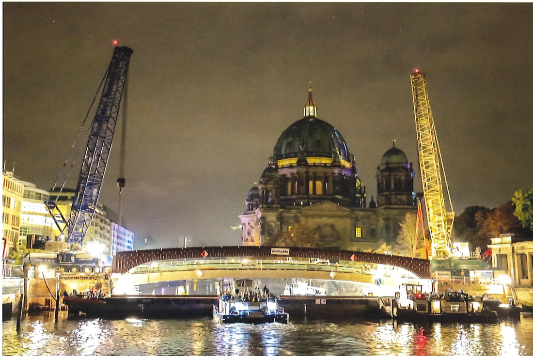
Bild 12.12: Montage der Stahlträger des Überbaus in einer Nachtsperrpause der Spree (Quelle: Ingenieurbüro Grassl Berlin)
