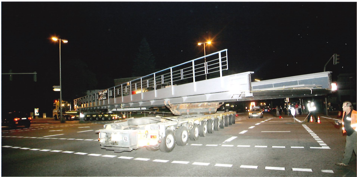
Bild 15.1: Transport eines Brückenteils für ein Hamburger Bauvorhaben (Foto: Spedition Gutmann GmbH & Co. KG)
