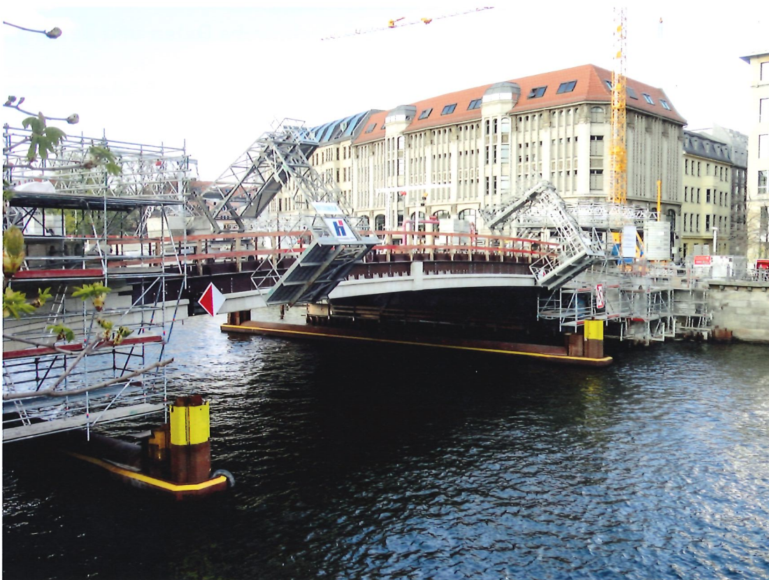
Bild 12.13: Montage der Natursteinverkleidung (Foto: Steffen Metzner, ibb Mangold mbH Berlin)
