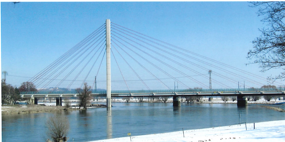
Bild 3.13: Elbebrücke Niederwartha, S 84 (Foto: LAP CONSULT)
