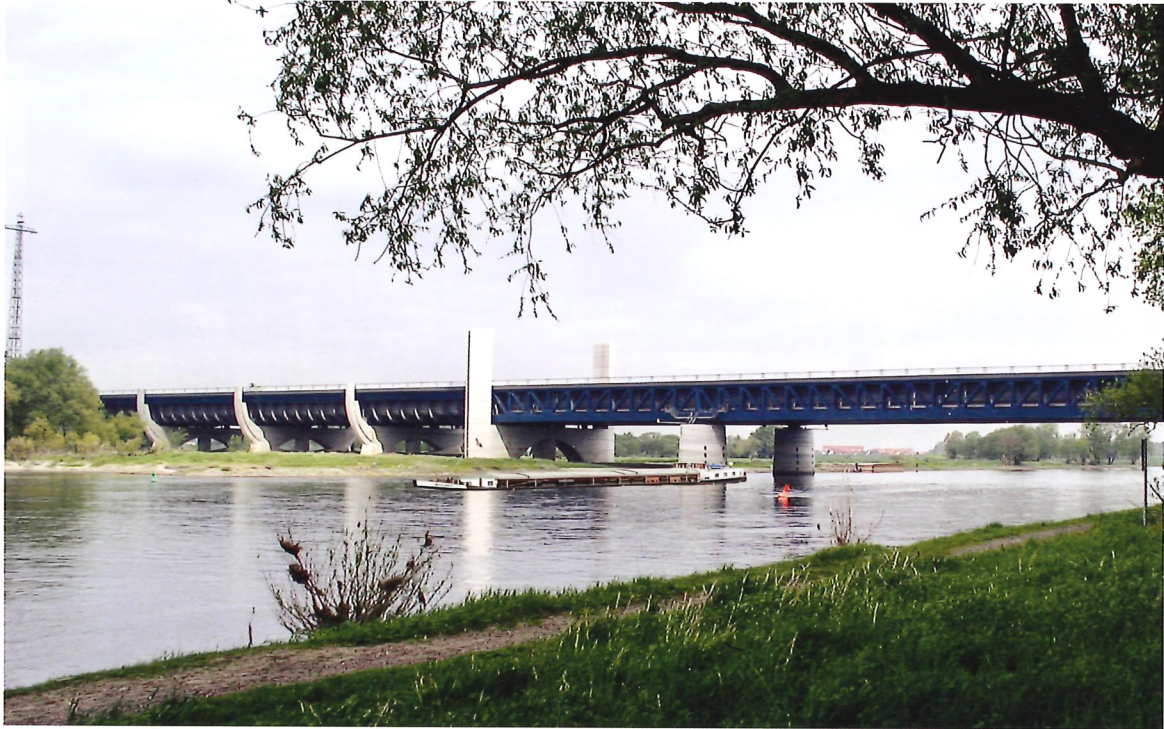
Bild 3.7: Kanalbrücke Magdeburg, “©wna-magdeburg.wsv.de”
