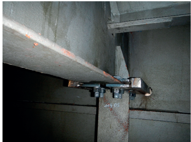
Bild 11.8: Verstärkte Rahmenecke (Quelle: Straßen.NRW)
