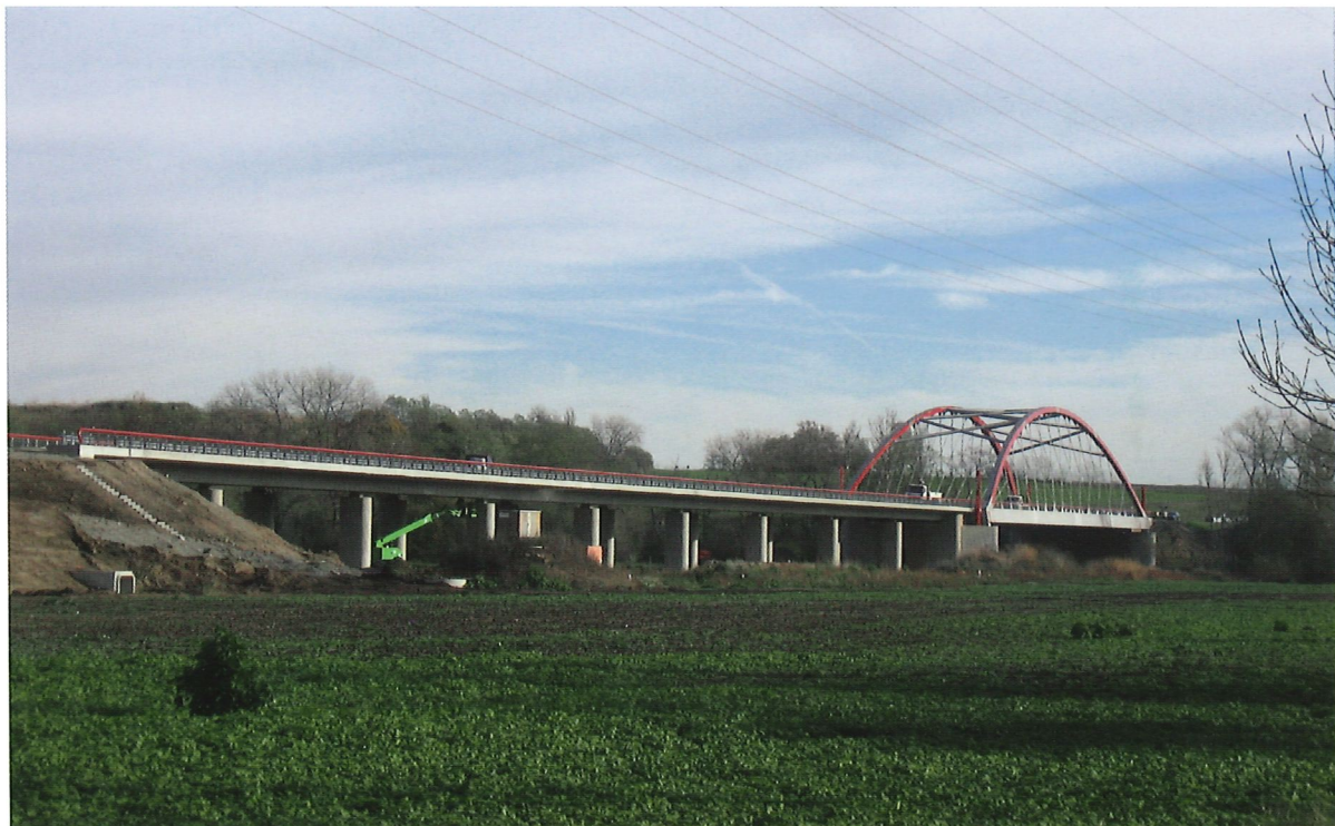
Seitenansicht (Quelle: Landesstraßenbaubehörde Sachsen-Anhalt, Regionalbereich West)
