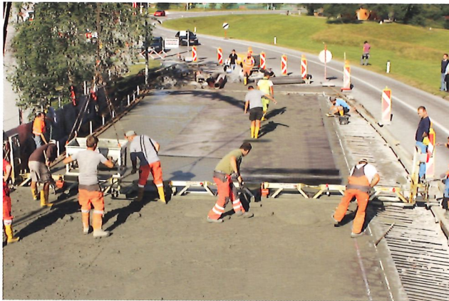
Bild 7.16: Gesamtübersicht Herstellung Textilbeton (BA1) (Foto: Gerhard Umfer)
