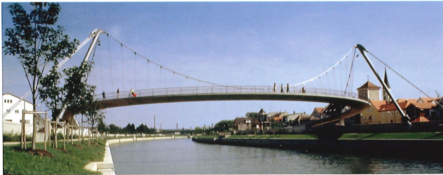
Bild 5.14: Fußgängerbrücke Kelheim, die erste einseitig aufgehängte, gekrümmte Hängebrücke (schlaich bergemann und partner)
