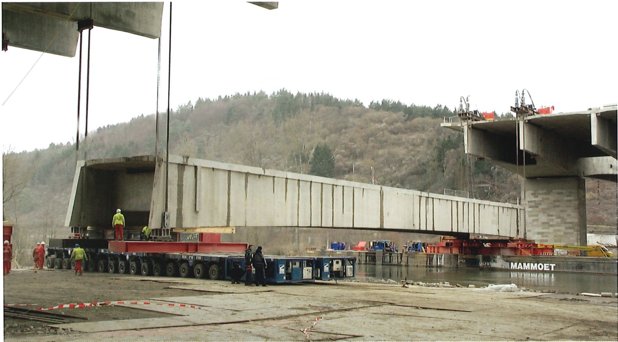
Bild 15.5: Aufnahme abgebrochenes Fahrbahnteil durch SPMT/s (Foto: MULTILIFT Transportsysteme Deutschland GmbH & Co. KG)
