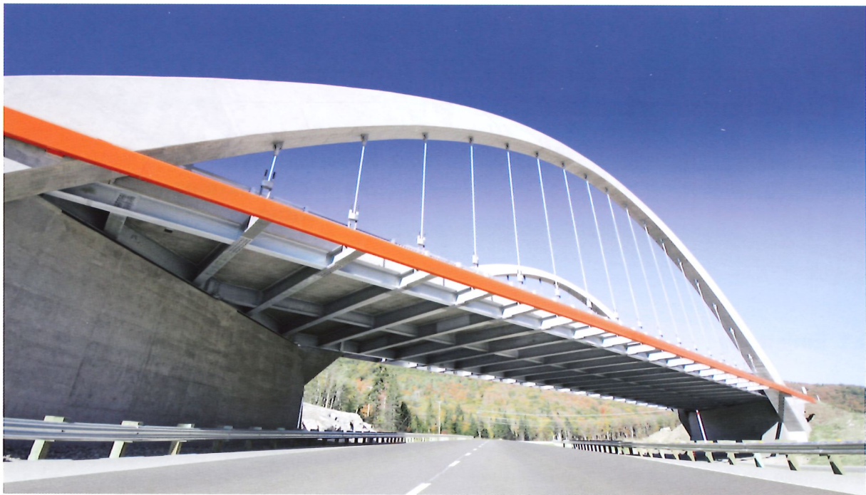
Bild 14.1: An der Stoneham-Brücke in Quebec kamen feuerverzinkte Stahlbauteile und feuerverzinkter Bewehrungstahl zum Einsatz. (Foto: American Galvanizers Association)
