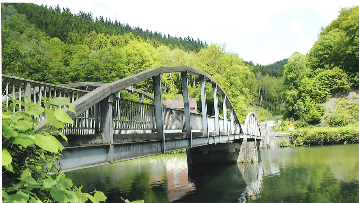
Bild 14.7: Baujahr 1987: Die feuerverzinkte Hölmecke-Brücke (Foto: Institut Feuerverzinken)
