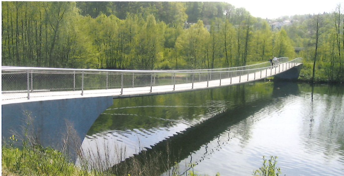
Bild 5.11: Fahrradbrücke in Minden (Glacisbrücke) (Weiss)
