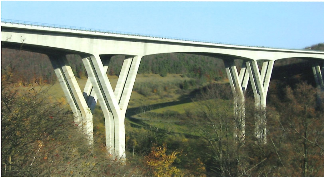
Bild 9.11: Talbrücke Zahme Gera (Foto: DEGES Deutsche Einheit Fernstraßenplanungs- und Bau GmbH)
