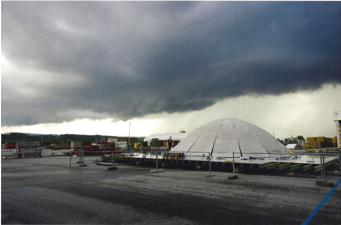
Bild 13.14: Fertiggestellte Kugelschale (Foto: TU Wien)
