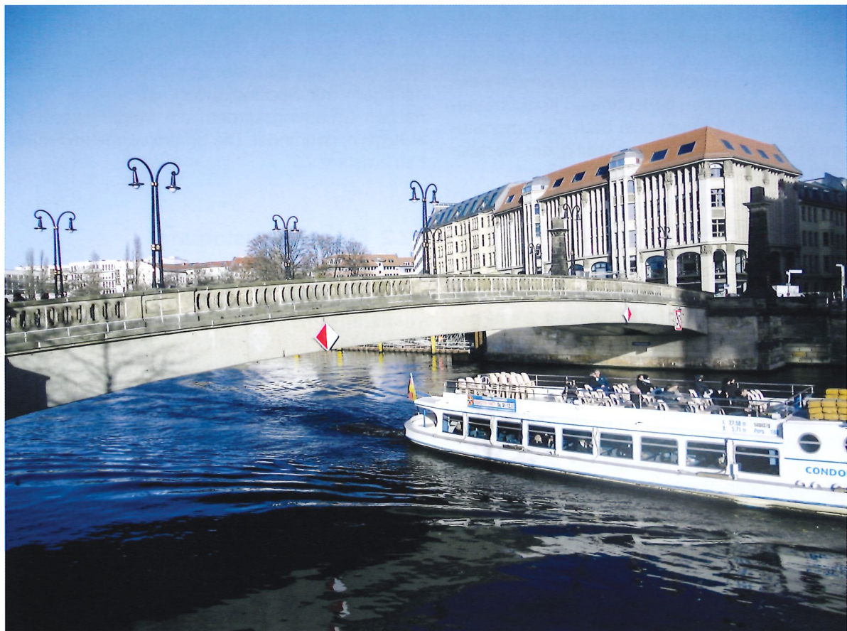
Bild 12.2: Bestandsbauwerk, Seitenansicht Süd, Blickrichtung Ost (Foto: Michael Hänig, ibb Mangold mbH Berlin)
