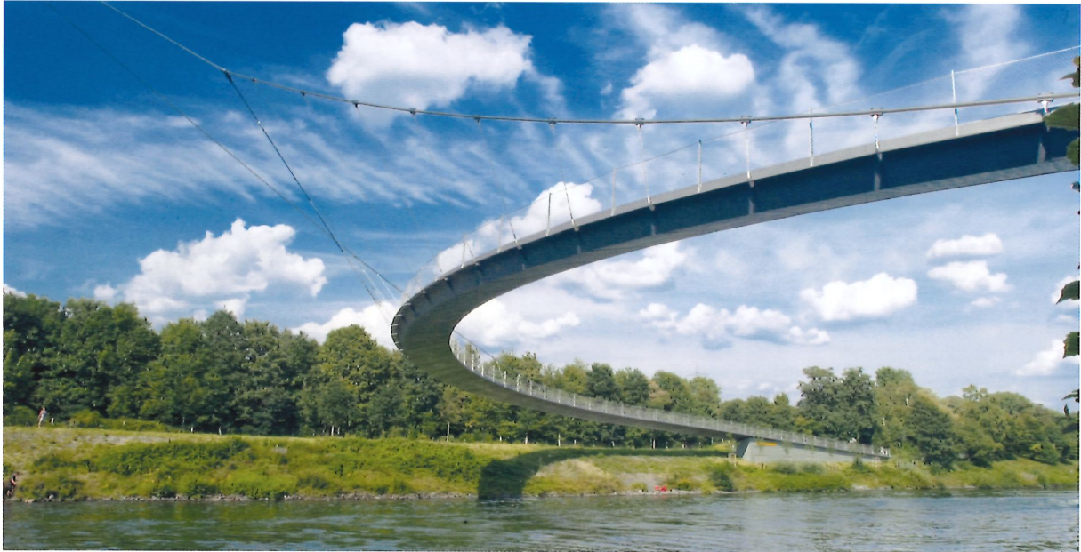
Bild 5.19: Stützenlose Kabelverankerungen bei der integralen Fußgängerbrücke am Hafen Grimberg in Gelsenkirchen (schlaich bergemann und partner / Michael Zimmermann)
