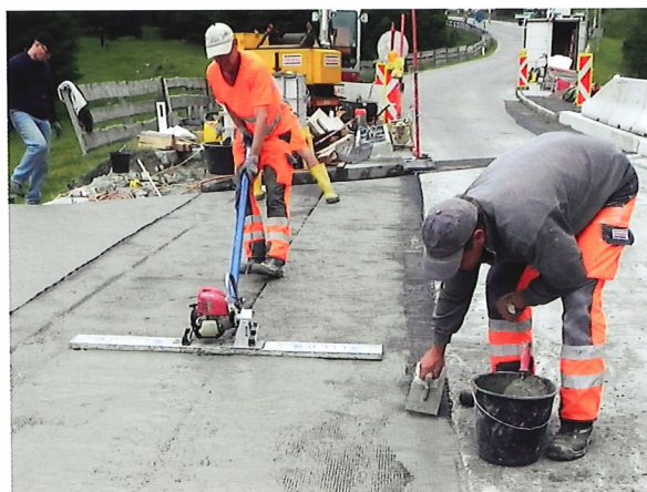
Bild 7.12: Einrütteln der textilen Bewehrung (BA2) [7] (Foto: Mario Hansl)
