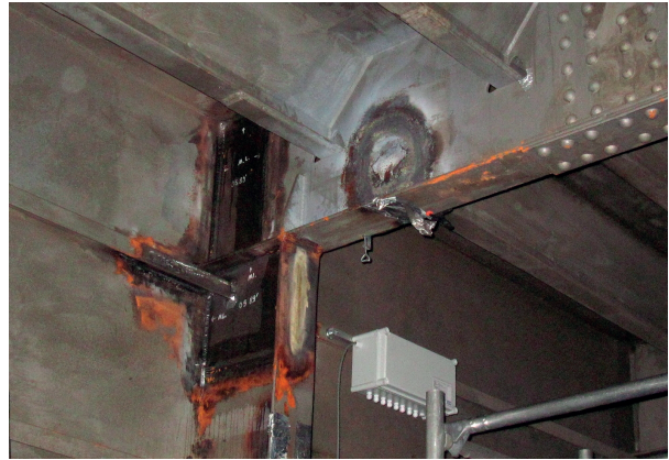
Bild 11.7: Instandsetzung der Rahmenecken mit Blechaustausch (Quelle: Straßen.NRW)
