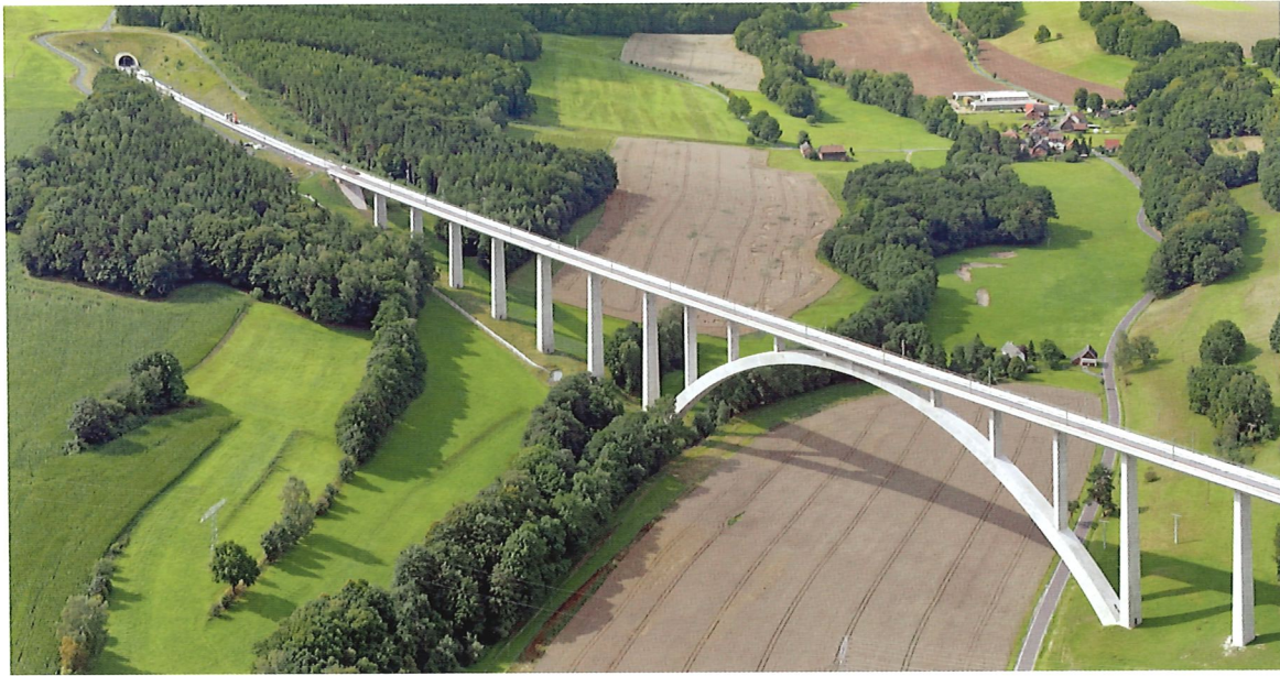
Bild 3.15: Grümpentalbrücke – NBS Ebensfeld–Erfurt (Foto: Hajo Dietz, Nürnberg)
