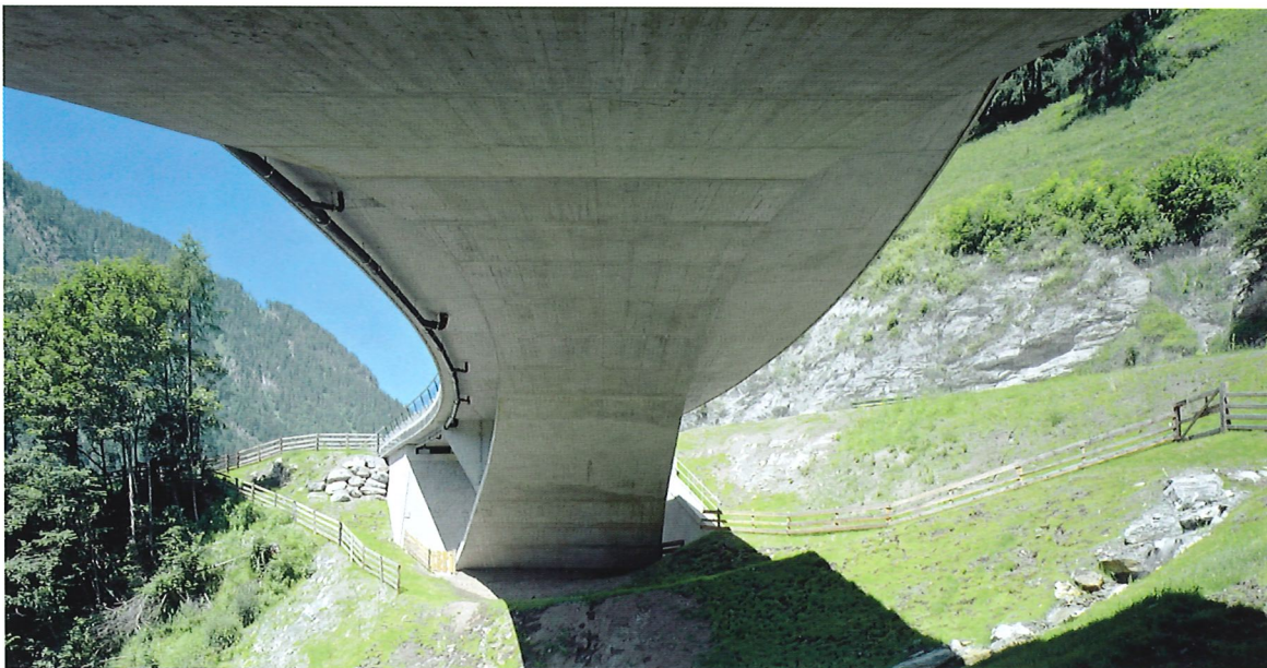
Bild 13.9: Untersicht der Egg-Graben-Brücke (Foto: © Pez Hejduk, Wien)
