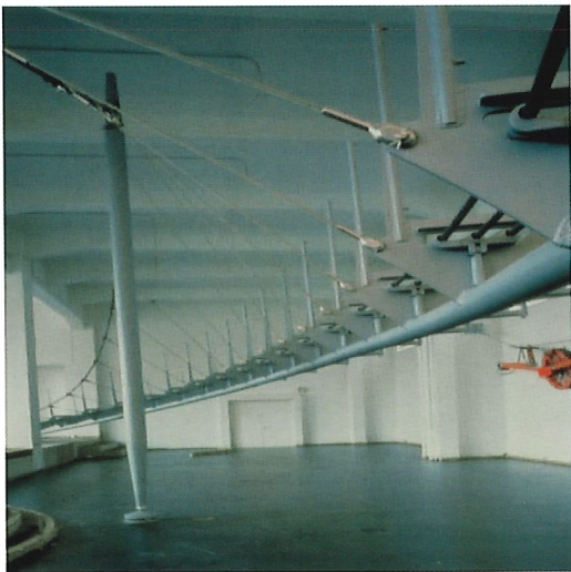
Bild 5.15: Brücke im Deutschen Museum, München, mit Druck- und Zugelementen
