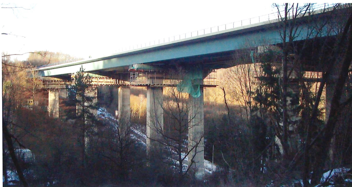
Bild 3.17: Talbrücke Windelbach, BAB 45 (Foto: Donges-SteelTec GmbH)
