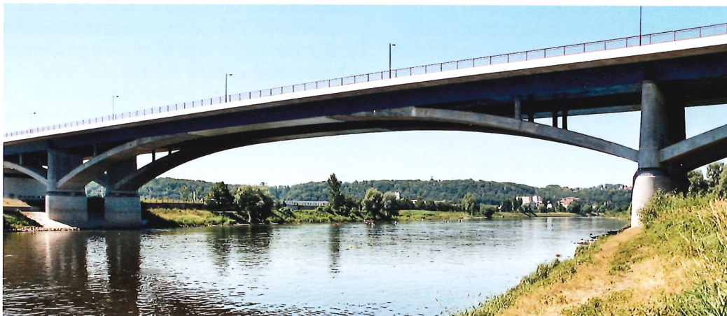
Bild 3.3: Elbebrücke Pirna, S 177 (Foto: Jürgen Stritzke)
