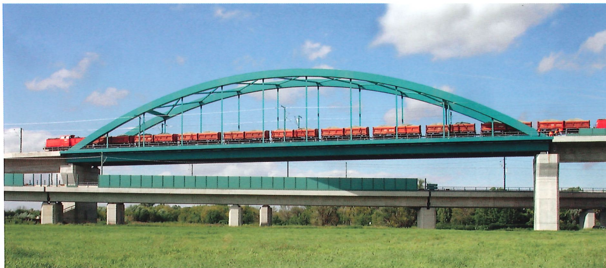
Bild 10.13: Belastungszüge auf der Stabbogenbrücke (Foto: Jörg Lutzens)
