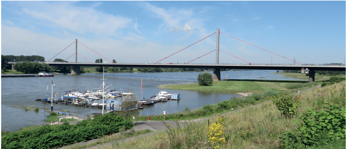
Bild 11.1: Rheinbrücke Leverkusen (Quelle: Straßen.NRW)
