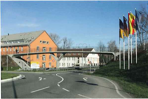
Bild 5.10: Fußgängerbrücke Cité Baden-Baden (schlaich bergermann und partner / Michael Zimmermann)
