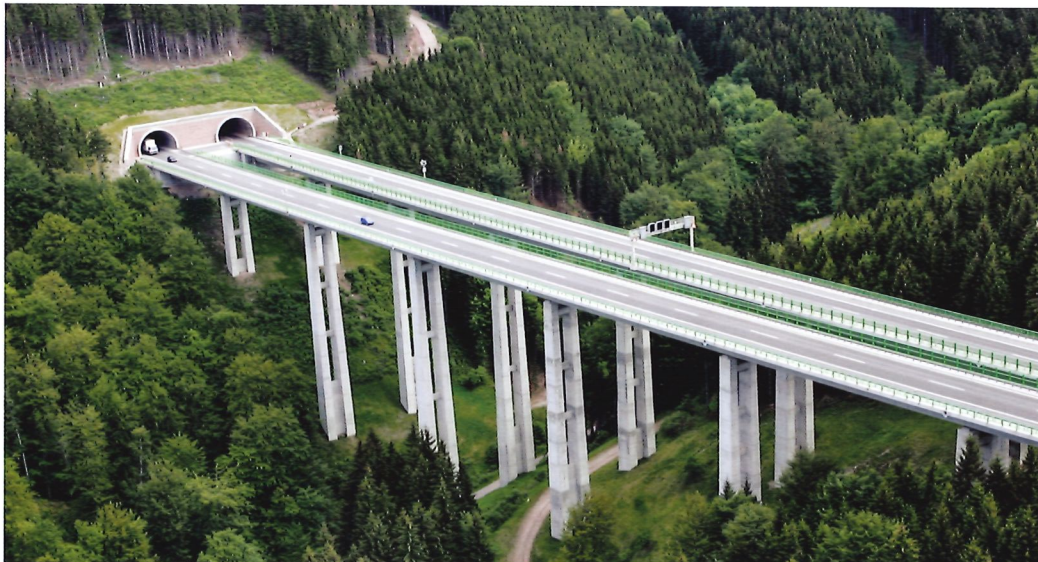
Bild 3.2: Schwarzbachtalbrücke, BAB 71 (Foto: DEGES ari)
