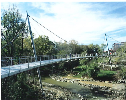
Bild 5.17: Umkehrung der Mastpositionen bei der Liberty Bridge, USA (Jürgen Schmidt, Köln)
