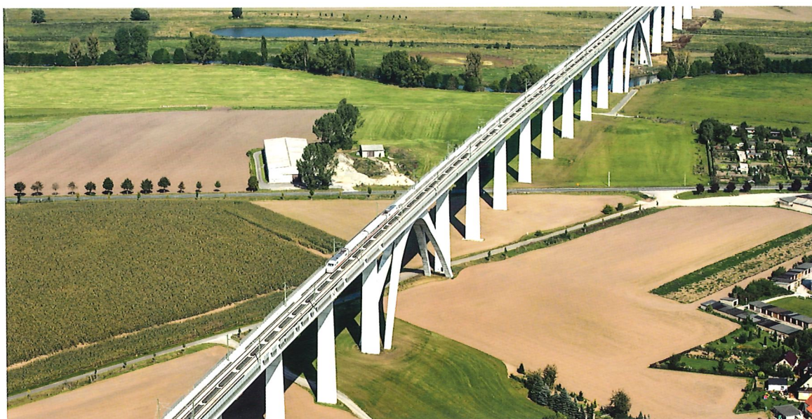
Bild 3.19: Unstruttalbrücke, NBS Erfurt–Halle/Leipzig (Foto: DB AG)
