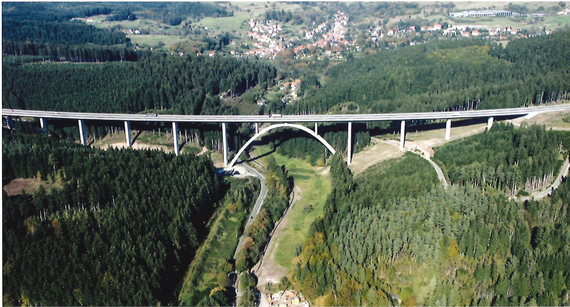
Bild 3.5: Talbrücke Albrechtsgraben, BAB 71 (Foto: DEGES ari)
