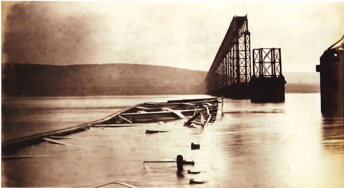
Bild 1.17 Firth of Tay Bridge nach dem Einsturz,
