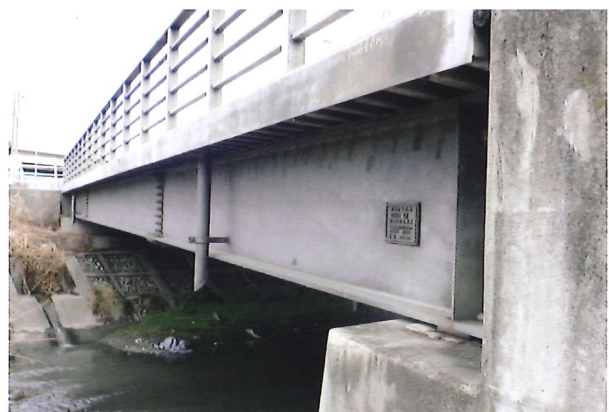
Bild 14.6: Baujahr 1964: Die feuerverzinkte Shin-Nukui-Brücke (Foto: HDGASA)
