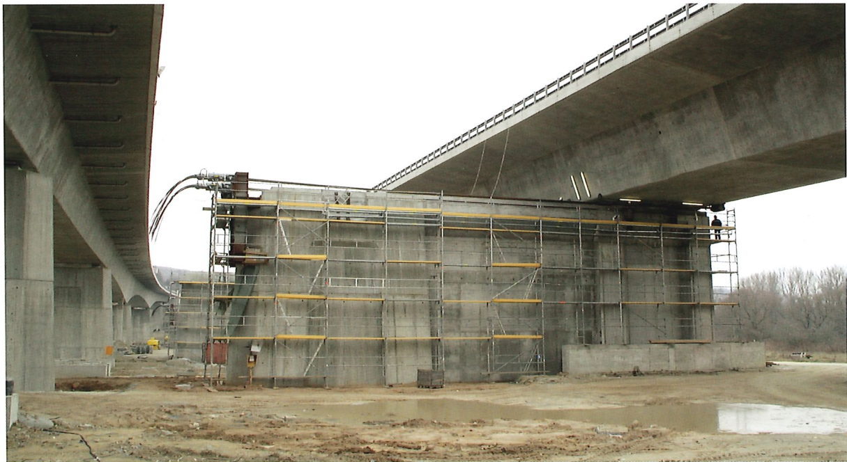
Bild 15.6: Einsatz von Litzenhebern beim Vershub des neuen Brückenbauwerks, Mainbrücke Randersacker (Foto: MULTILIFT Transportsysteme Deutschland GmbH & Co. KG)
