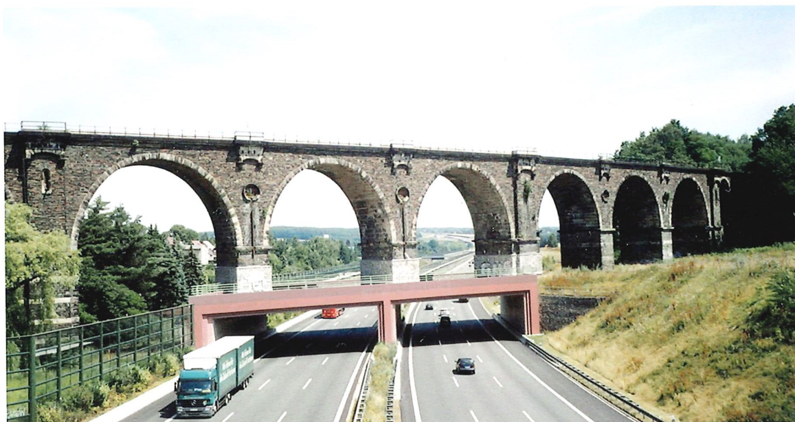
Bild 3.6: Bahrmühlenviadukt Chemnitz – Unterführung der Autobahn BAB 4 (Foto: Jürgen Stritzke)
