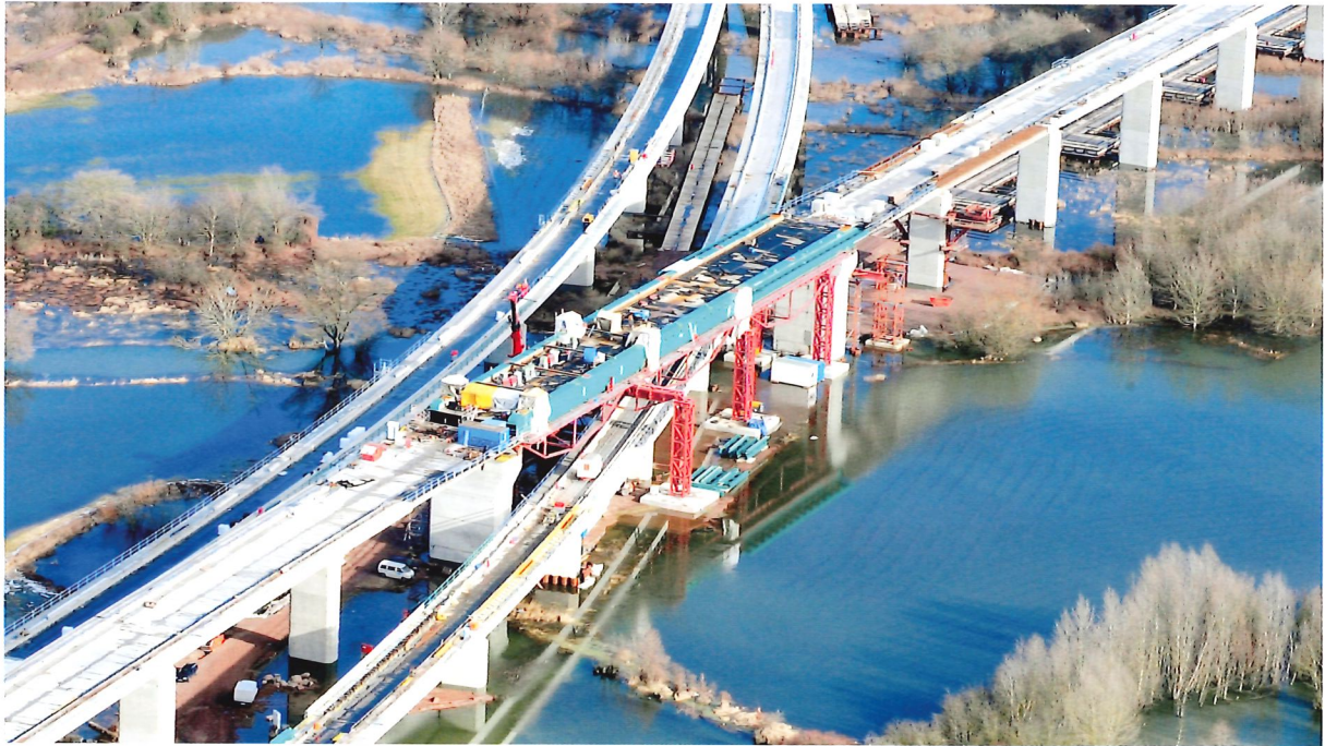
Bild 10.11: Montage von Fahrbahn und Versteifungsträger (Foto: DB AG)
