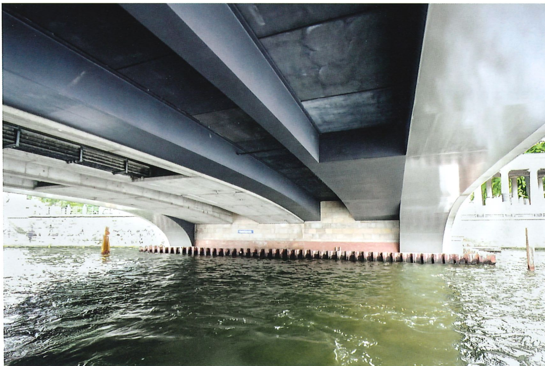
Bild 12.15: Unteransicht der Friedrichsbrücke nach Fertigstellung mit Blickrichtung auf das Widerlager Ost (Quelle: Ingenieurbüro Grassl Berlin)
