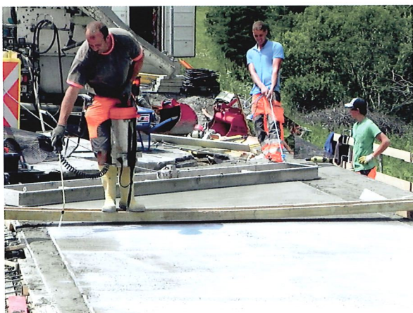
Bild 7.11: Auftragen des Verdunstungsschutzes (BA1) [7] (Foto: Mario Hansl)
