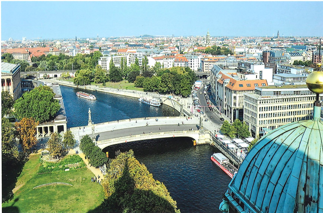
Bild 12.14: Übersichtsbild der Friedrichsbrücke, Blickrichtung Nord vom Berliner Dom nach erfolgter VOB-Abnahme (Quelle: Ingenieurbüro Grassl Berlin)
