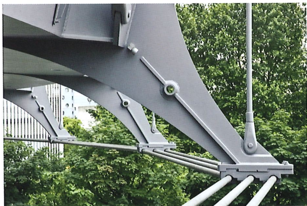
Bild 5.26: Ringseile im Detail: Passerelle La Défense, Paris, Frankreich (schlaich bergemann und partner / Michael Zimmermann)
