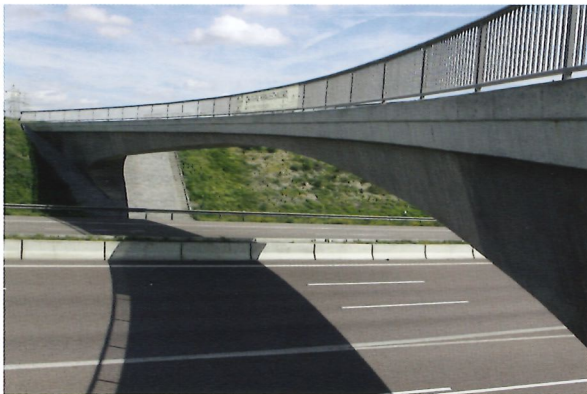
Bild 17.4: Gekrümmte Autobahnüberführung der A 8 (Foto: Sebastian Wilhelm)
