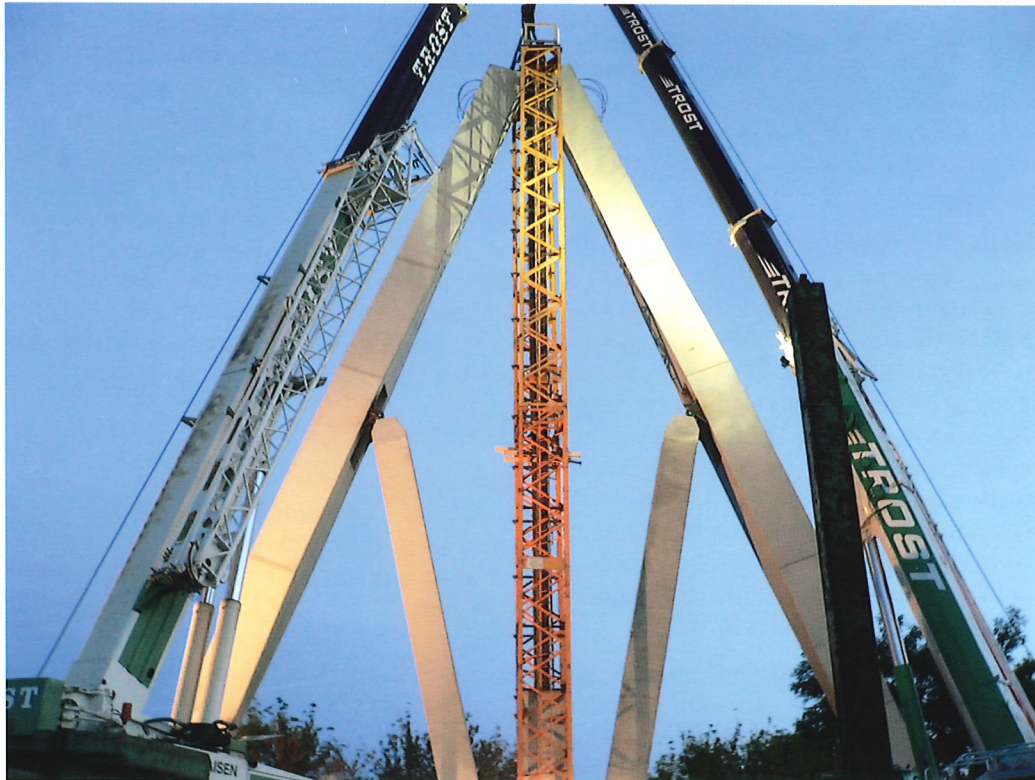
Bild 13.23: Großversuch für die Ausführung der S7-Brücken: Brücke in Bauphase 5 (Foto: TU Wien)
