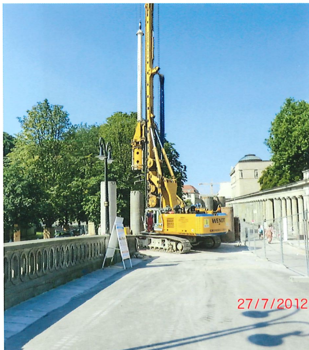
Bild 12.10: Bohrpfahlarbeiten am Widerlager Seite Südwest unter beengten Platzverhältnissen (Foto: Steffen Metzner, ibb Mangold mbH Berlin)
