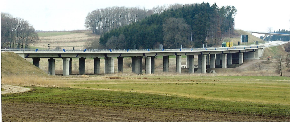
Bild 3.12: Brücke über die Kleine Laber, B 15n (Foto: Jürgen Stritzke)
