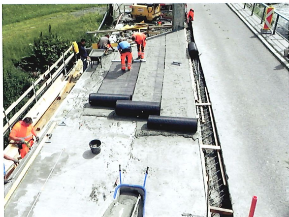
Bild 7.9: Verlegen der textilen Bewehrung (BA1) [7] (Foto: Mario Hansl)
