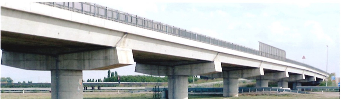
Bild 9.7: Isola della Scala Bridge, Italien [12]
