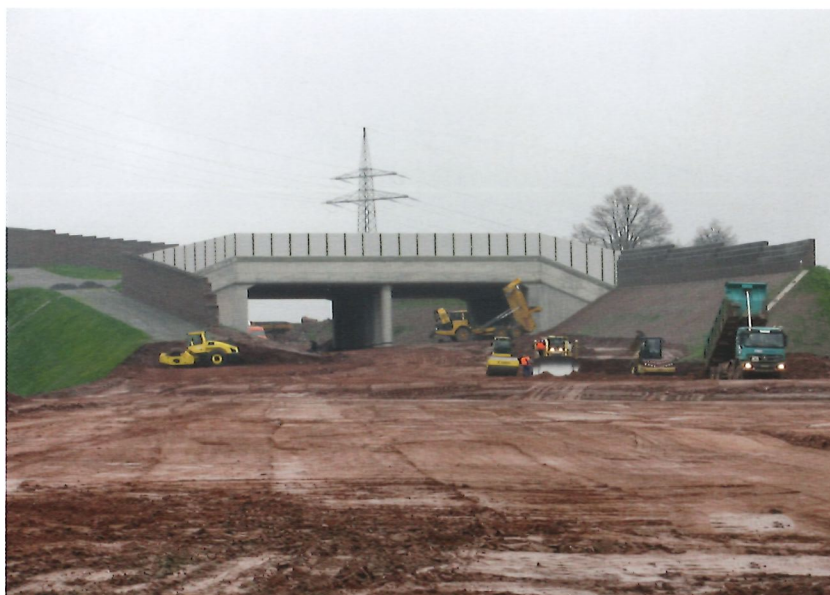
Brücke im Bauzustand (Quelle: Hessen Mobil)
