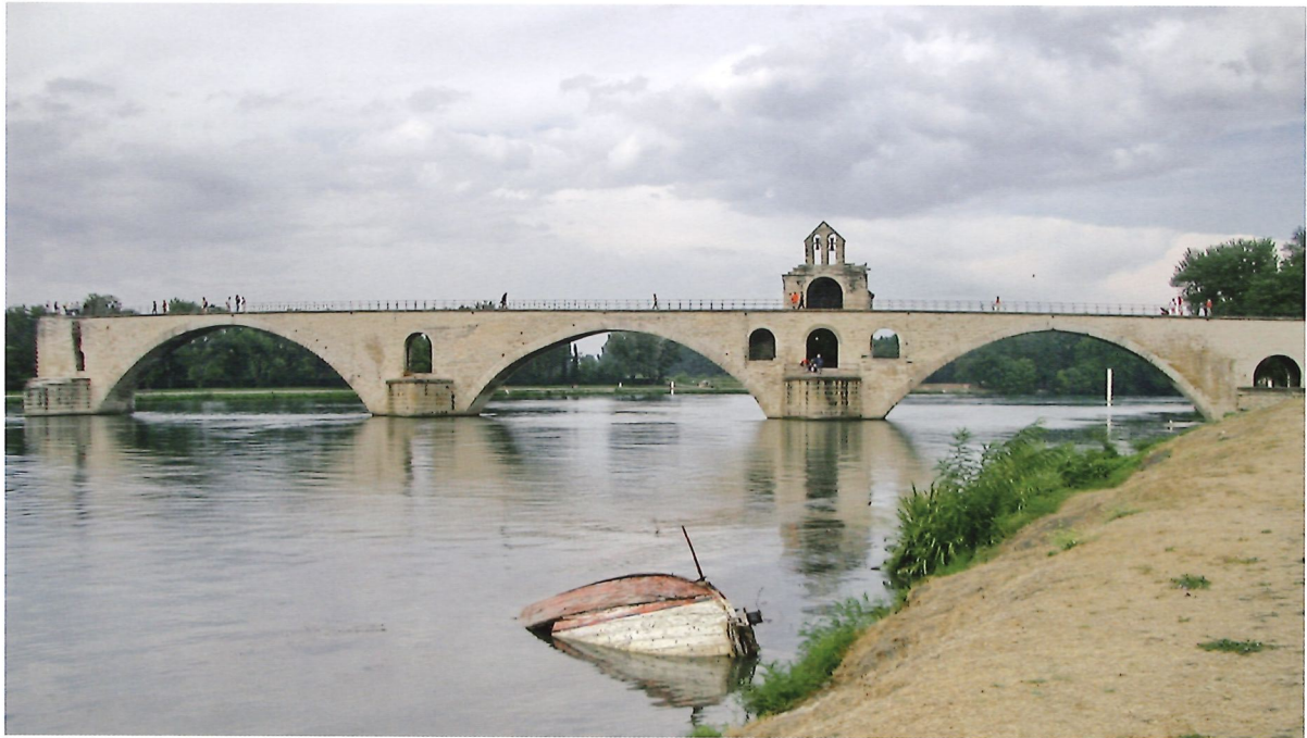
Bild 1.21 Brücke von Avignon, gebaut von den „Frères du Pont“ unter Leitung von BÉNEZET, Foto: MANFRED CURBACH
