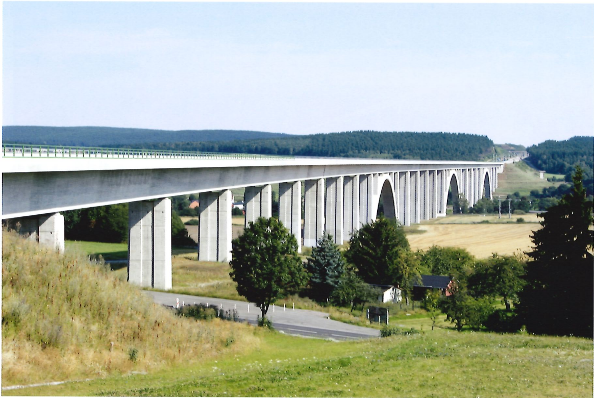
Bild 3.16: Ilmtalbrücke, NBS Ebensfeld–Erfurt (Foto: Jürgen Stritzke)
