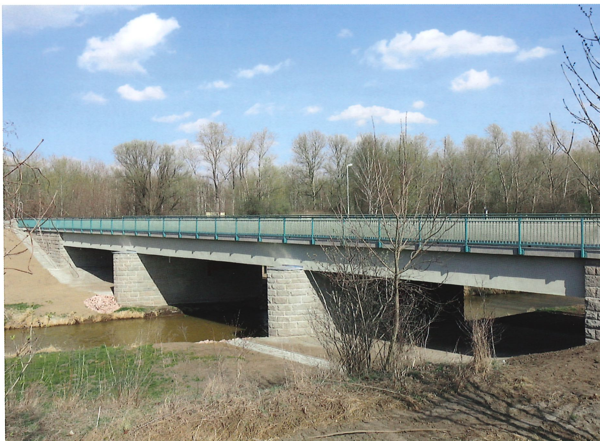
Seitenansicht (Quelle: Landesamt für Straßenbau und Verkehr, Niederlassung Leipzig)
