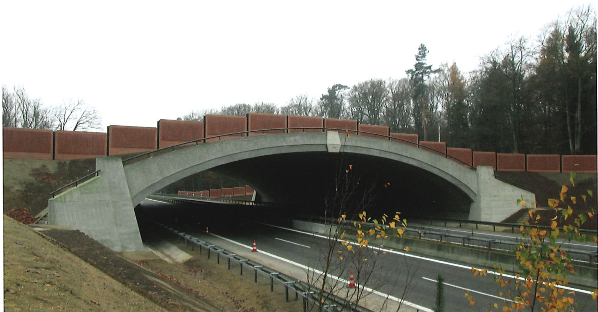
Seitenansicht der fertig gestellten Grünbrücke (Quelle: Landesbetrieb Straßenwesen Brandenburg)
