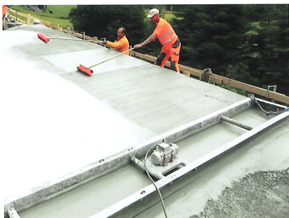
Bild 7.13: Herstellung des Besenstrichs (BA2) [7] (Foto: Mario Hansl)
