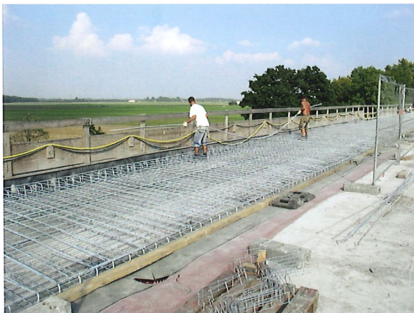
Bild 14.10: Einsatz von feuerverzinktem Bewehrungsstahl an Brückenkappen (Foto: Institut Feuerverzinken)
