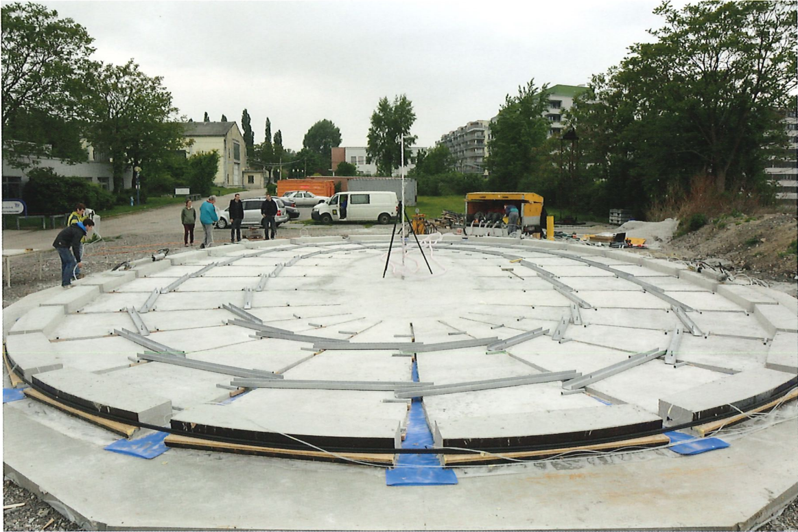
Bild 13.16: Ebene Betonplatte für die Freiformschale (Foto: TU Wien)
