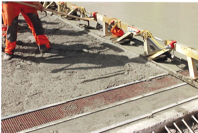
Bild 7.18: Ausbildung der Arbeitsfuge (BA1) (Foto: Mario Hansl)
