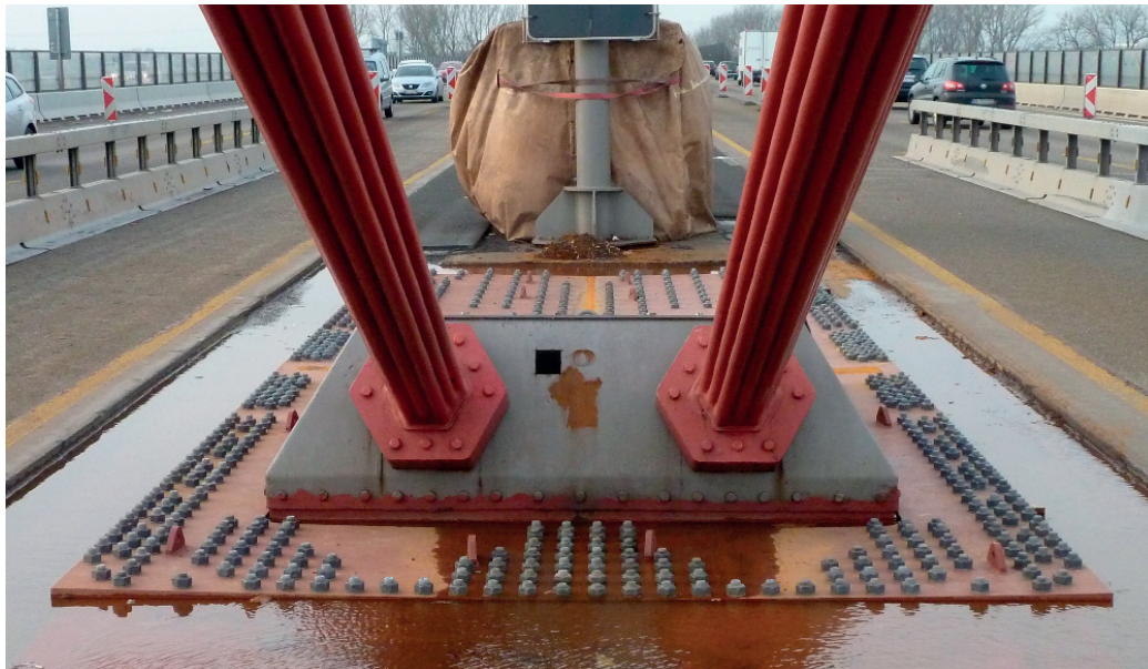
Bild 11.9: Verstärkung der Seilkammern (Quelle: Straßen.NRW)
