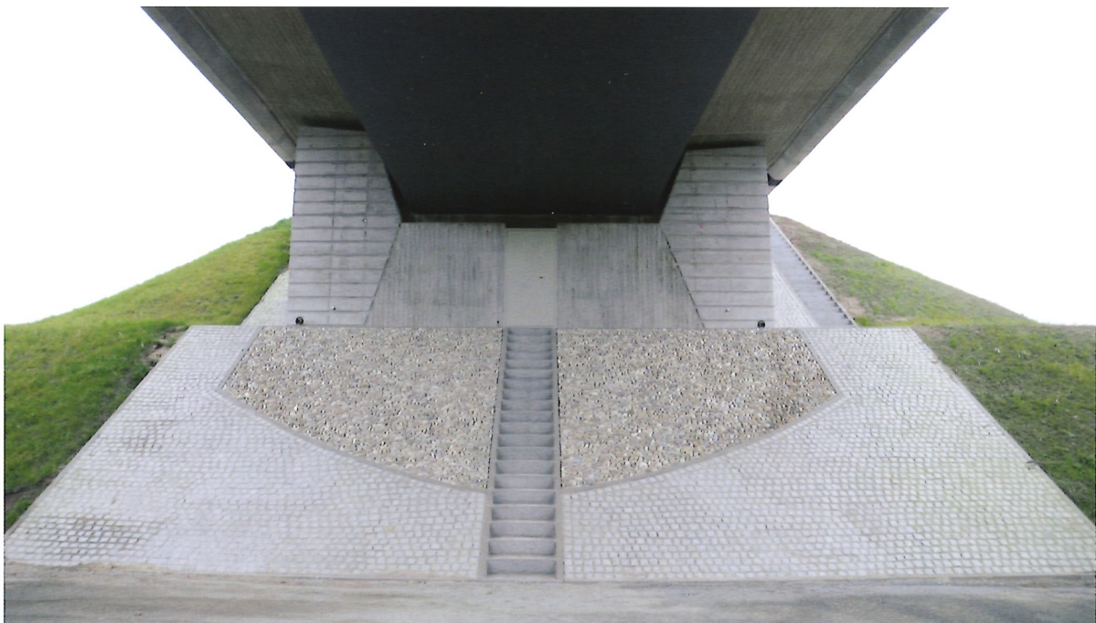
Detail Widerlager (Quelle: Landesbetrieb Straßenwesen Brandenburg)
