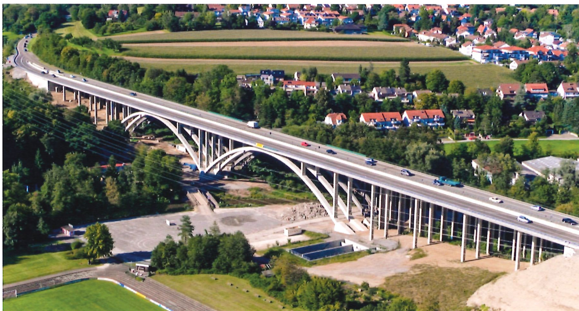
Bild 3.18: Murrtaalbrücke, B 14 (Foto: Max Bögl)
