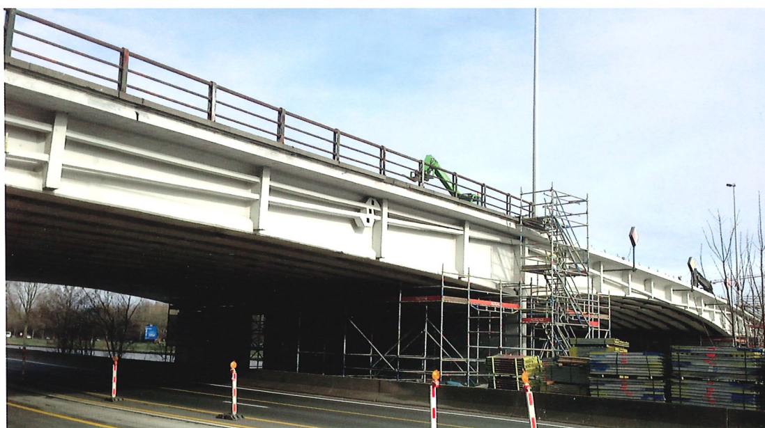
Bild 8.16: Seitenansicht von Vandepittes Dreifeldbrücke vor der Erneuerung der Träger (Foto: Luc Taerwe)
