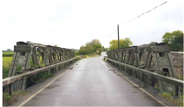
Bild 14.5: Baujahr 1942: Die feuerverzinkte Lydlinch-Brücke (Foto: Iqbal Johal)
