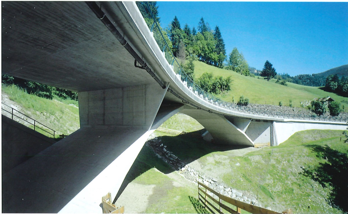
Bild 13.8: Seitenansicht der Egg-Graben-Brücke (Foto: © Pez Hejduk, Wien)
