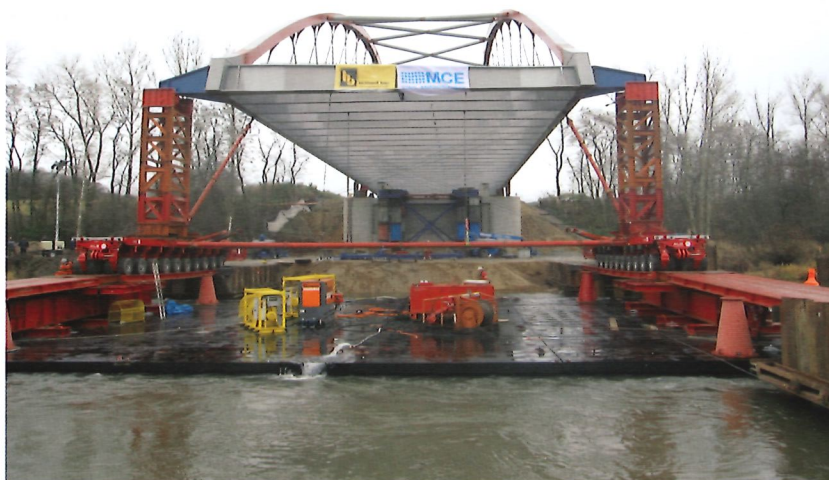
Einschub des Bogens (Quelle: Landesstraßenbaubehörde Sachsen-Anhalt, Regionalbereich West)
