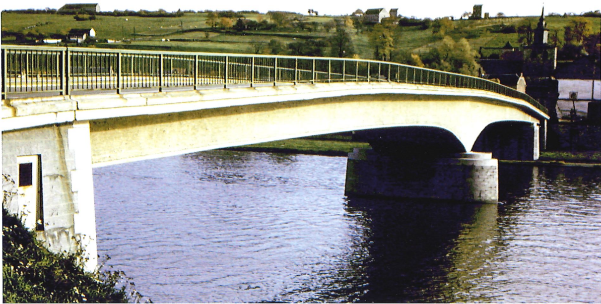
Bild 8.8: Brücke bei Sclayn über die Meuse (Foto: Magnel Laboratory for Concrete Research)
