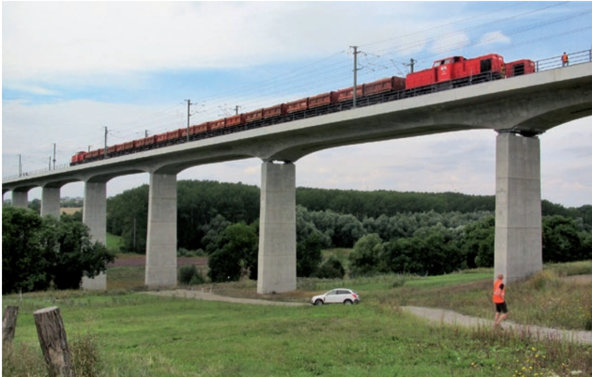
Bild 6 Belastungszüge bei den Probelastungen im August 2014
