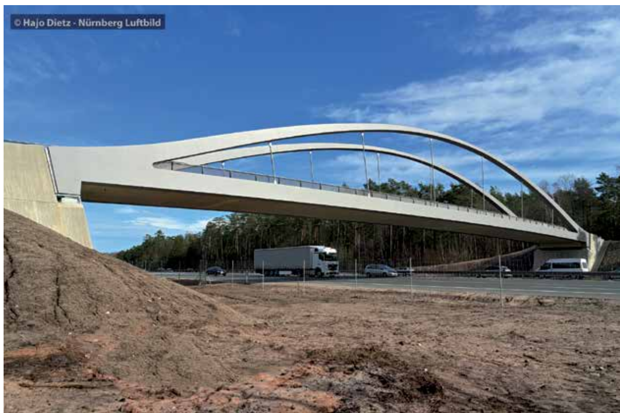
Seitenansicht des Ersatzneubaus BW 374b
