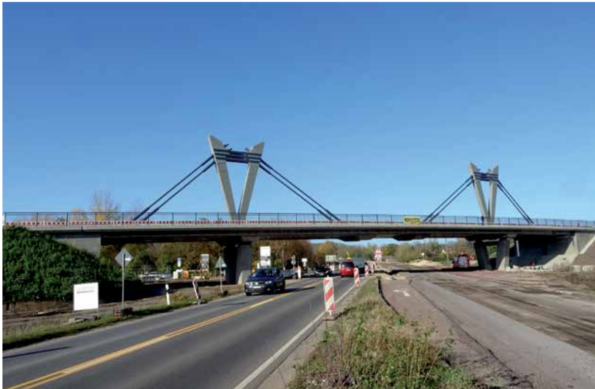
BW88 kurz vor Fertigstellung
