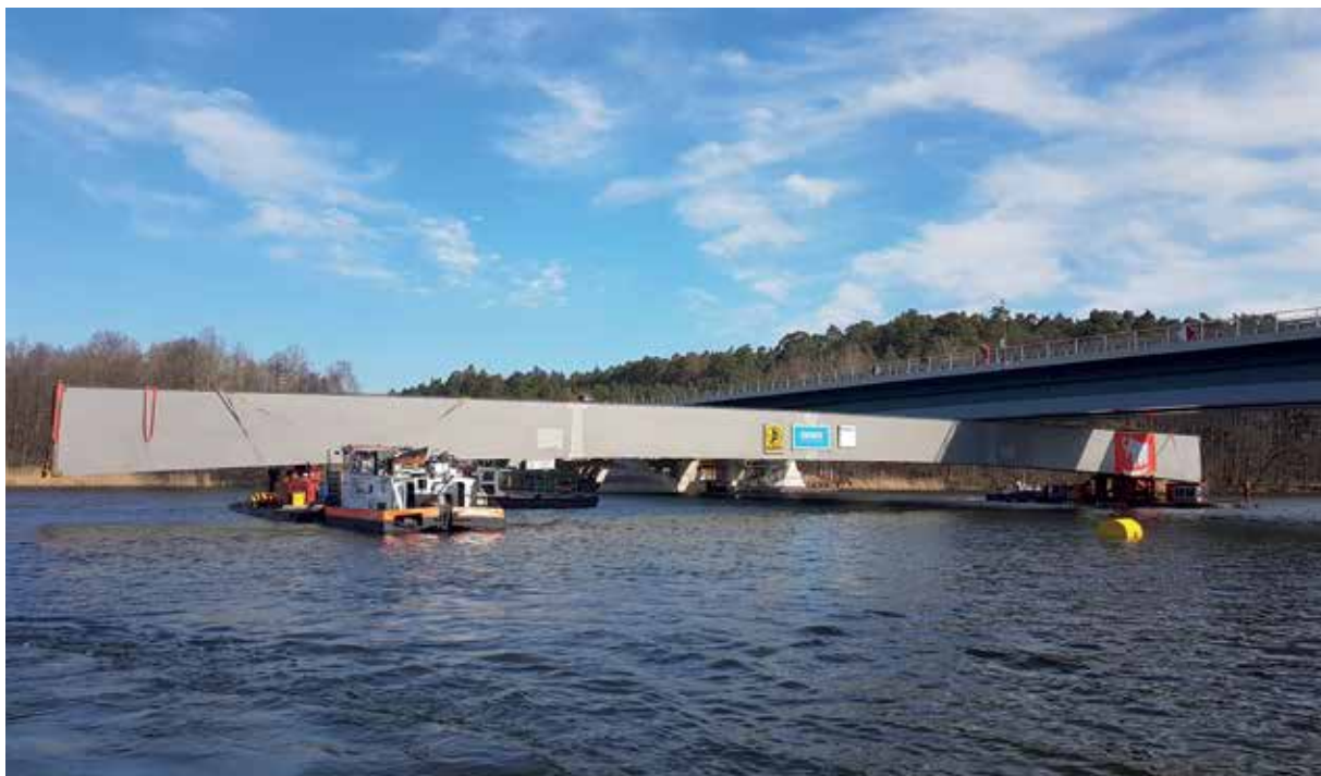
Einschwimmen eines Mittelträgers
