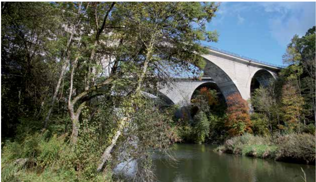
Bild 18 Auch die Widerlager der berühmten Stampfbetonbrücken über die Iller (1906) sind fast vollständig überwuchert. Foto: Nicolas Janberg (Structurae)
