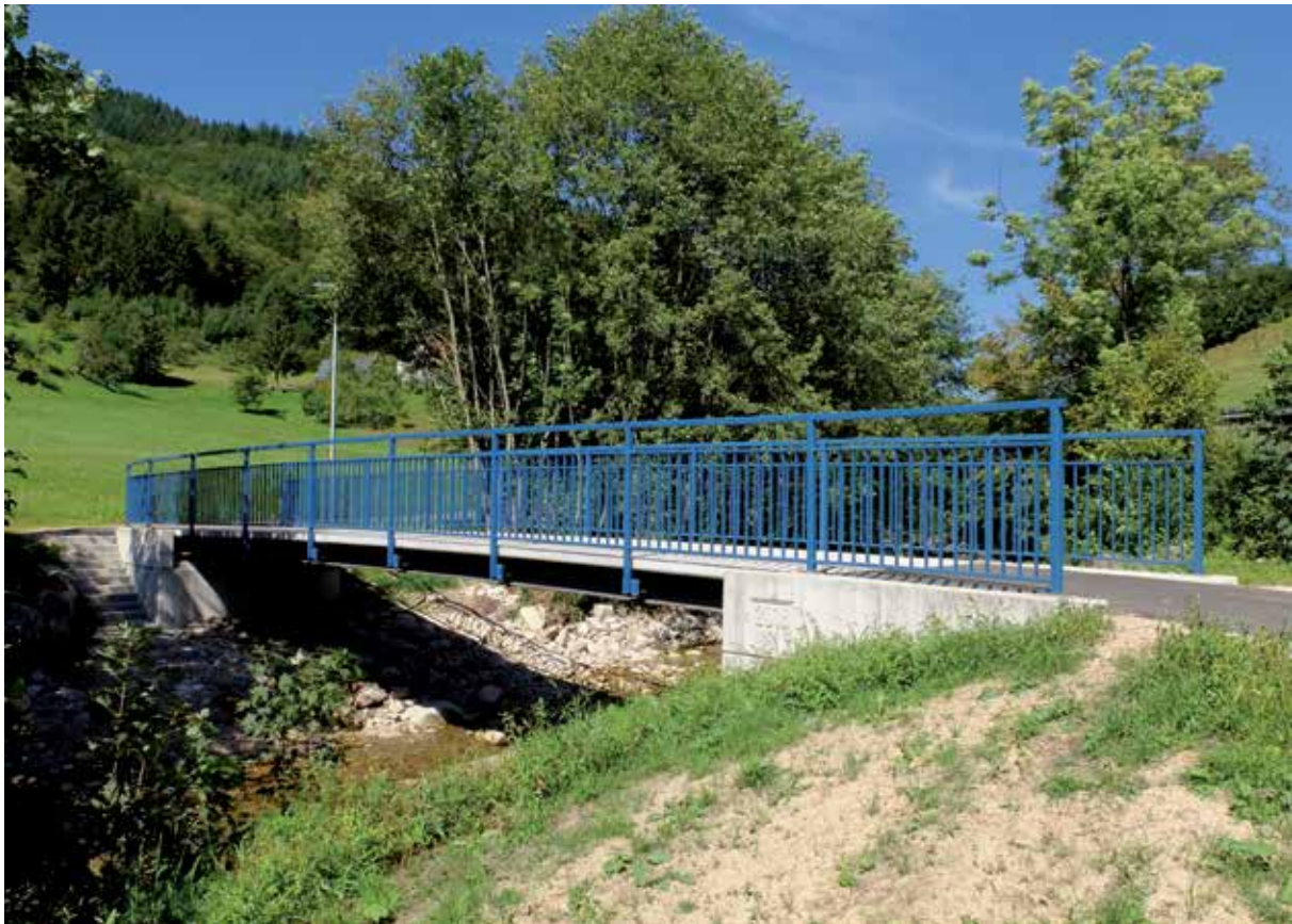
Bild 13 Ansicht der fertiggestellten Brücke
