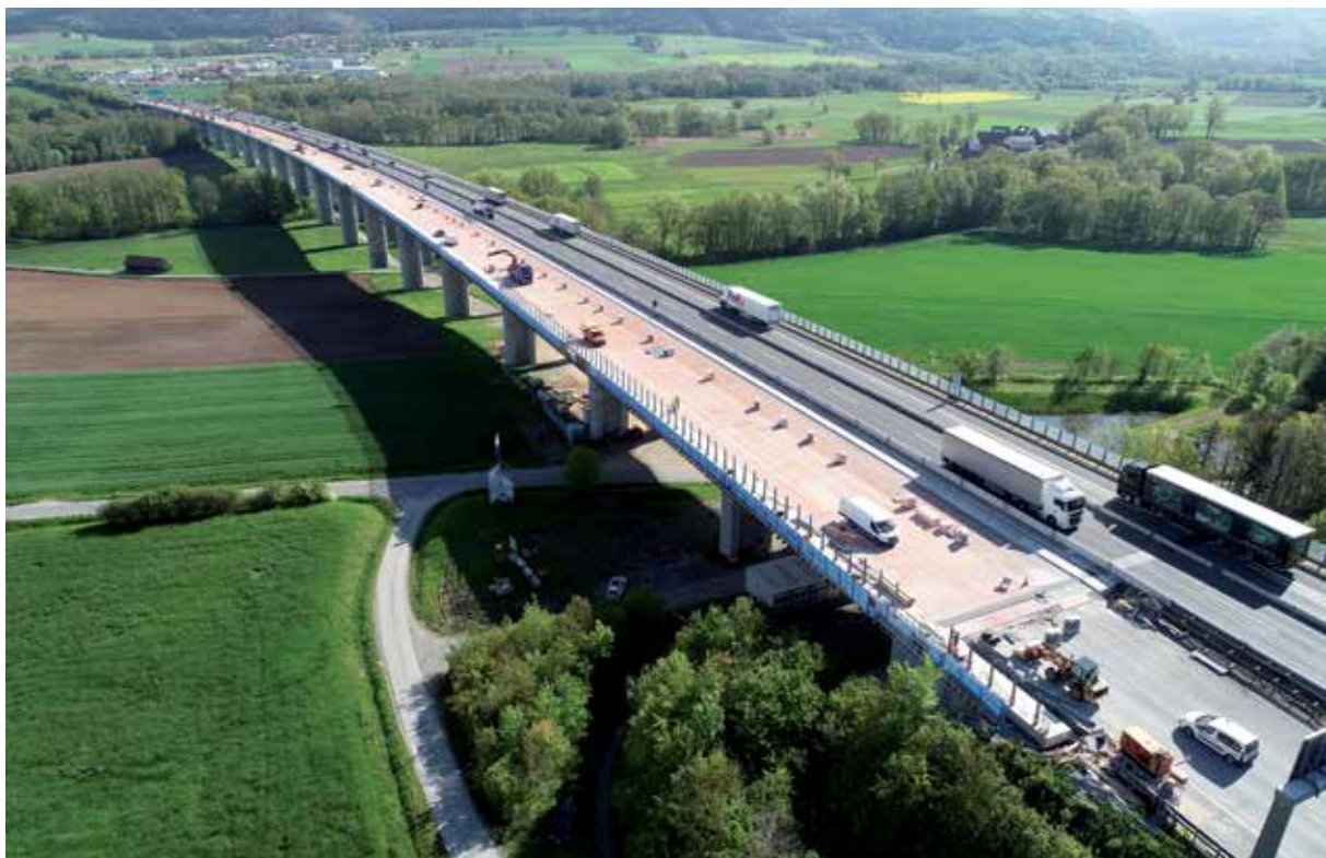
Talbrücke Lanzendorf während der Instandsetzungsarbeiten
