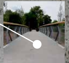
Brückenneubau in Weinstadt
