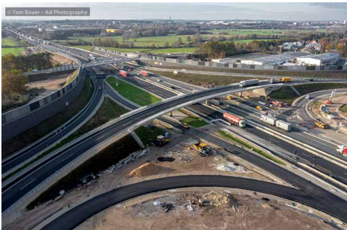
Luftbild der Verbindungsbrücke
