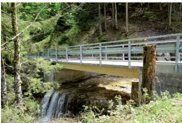
Bild 6 Fruttlibrücke in UHFB-Holz-Verbundbauweise (2020) Foto: E. Kälin
