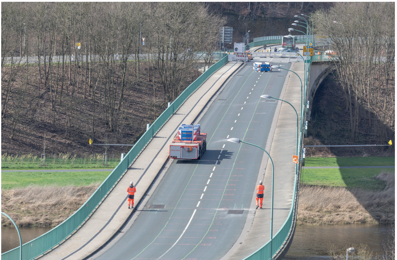
Bild 9: SPMT und Krangewichte auf Elbebrücke
