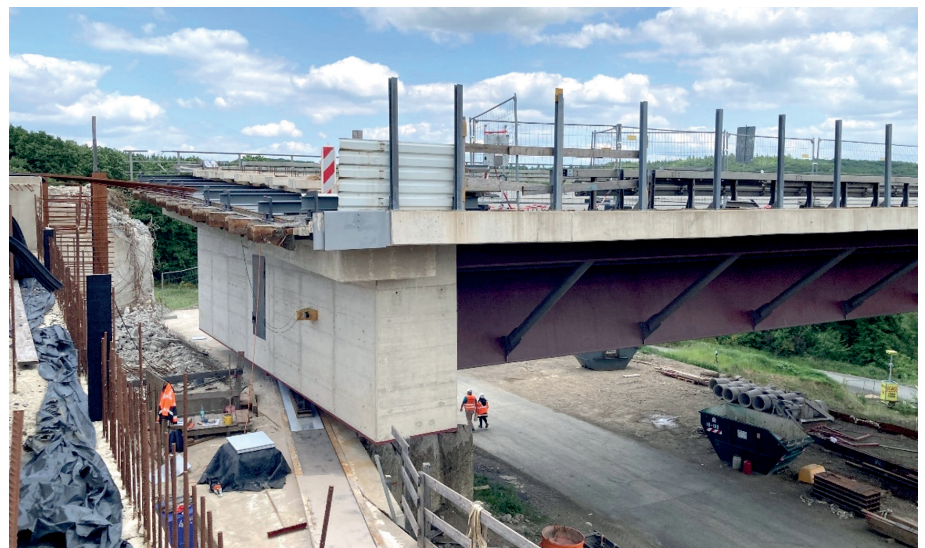
Bild 6: Versubdetail Widerlager
