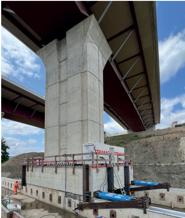
Bild 12: Pfeiler 20 mit Verschubbahn, unten im Bild ist die Antriebstechnik auf der Verschubbahn gut zu sehen Foto: KREBS+KIEFER
