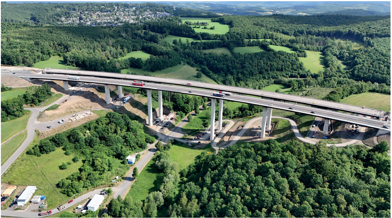
Bild 4: Luftbild Talbrücke Rinsdorf vor dem Querverschub
