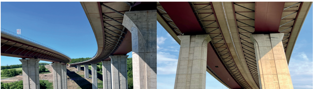
Bild 1: Untersichten der Überbauten vor (links) und nach dem Verschub (rechts)
