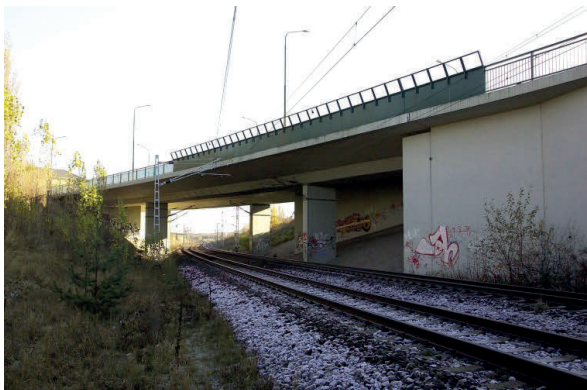
Bild 4 Seitenansicht der Brücke in Waren/Müritz
