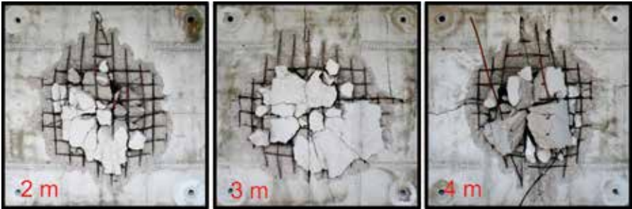
Bild 14: Einfluss der Fallhöhe auf das rückwärtige Schädigungsbild
