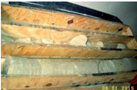
Bild 16: Bohrkern aus Fundament Pfeiler M1 (oben) und Pfeiler 16 (unten)
