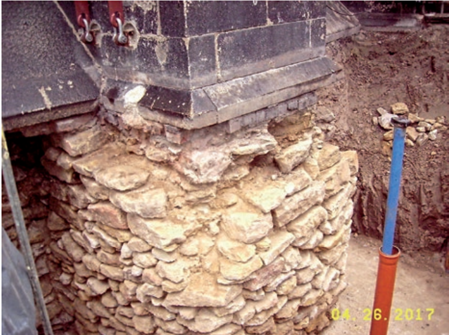
Bild 23: Bestandsfundament nach oberflächiger Reinigung
