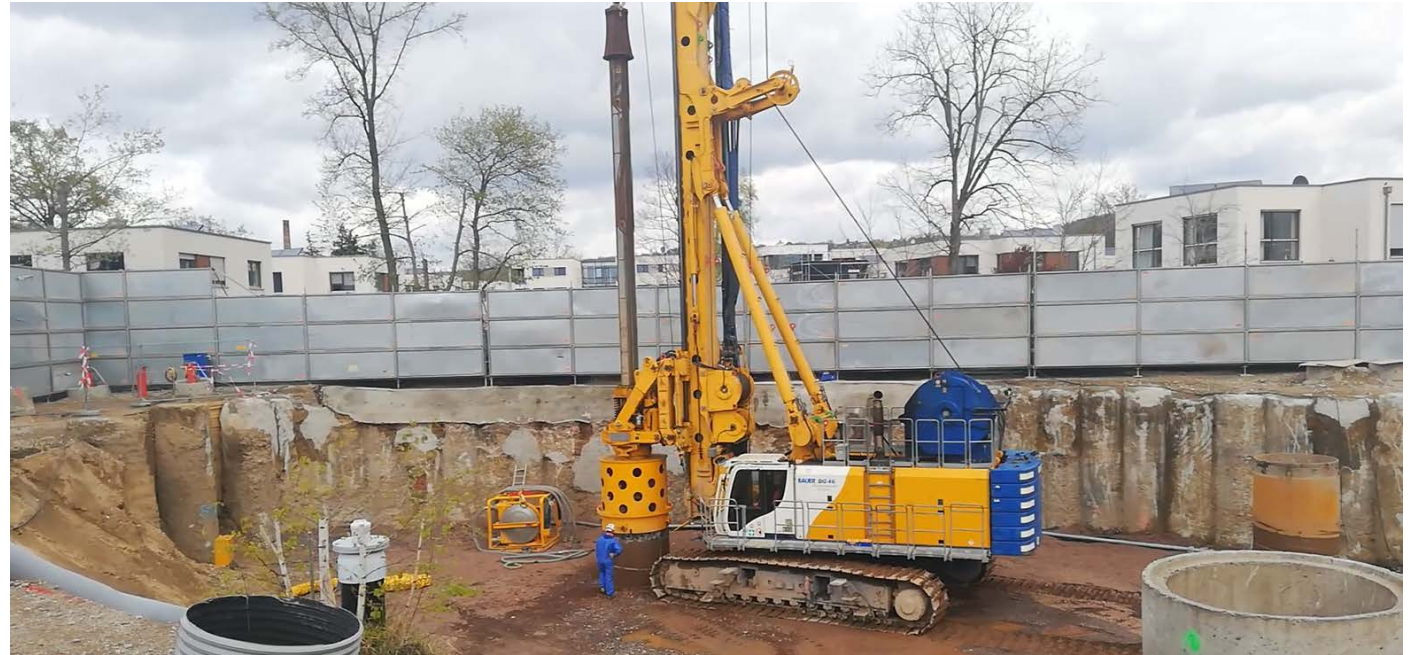
Bild: Großlochbohrung zur Entfernung von kontaminiertem Boden (ehem. chem. Reinigung in Dresden-Laubegast, Mai 2021)
