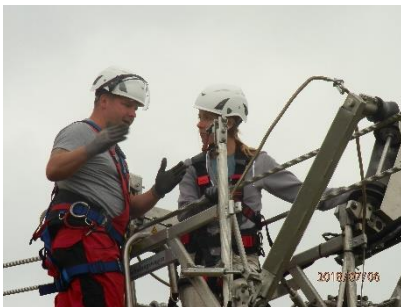
Anbringen eines Abstandshalters im Schulungswagen Foto: Omexom
