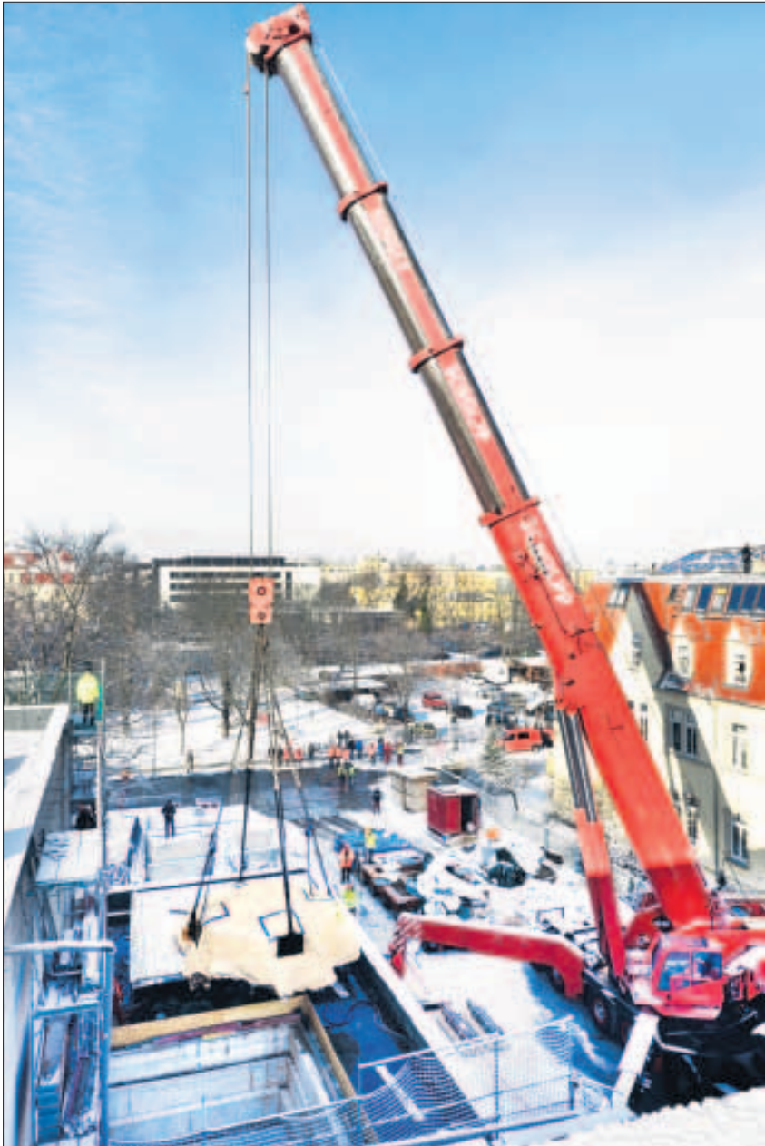
Mit einem der leistungsfähigsten Teleskopkräne Europas – die maximale Traglast liegt bei 700 Tonnen – wurden die beiden je 110 Tonnen schweren Teile des Zyklotrons in den Neubau der Protonentherapieanlage eingehoben. Foto:Thomas Albrecht
